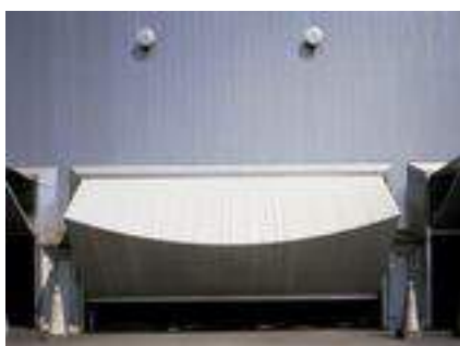
Fig 12 e 13_dettaglio del portone di ingresso della Fabbrica Ernsting di Santiago Calatrava.
