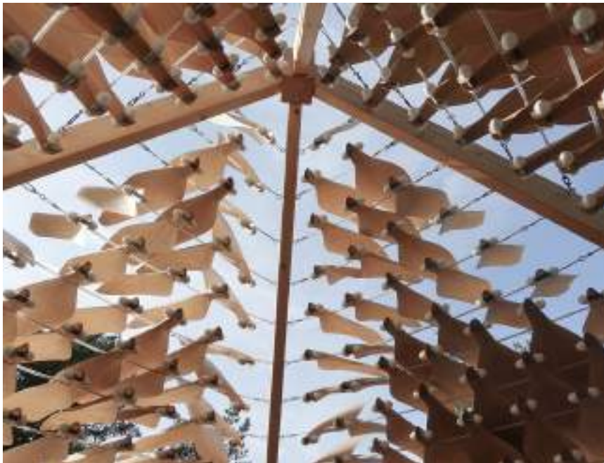
Fig 29_dettaglio dei singoli pannelli che costituiscono la copertura del padiglione e generano il movimento.
