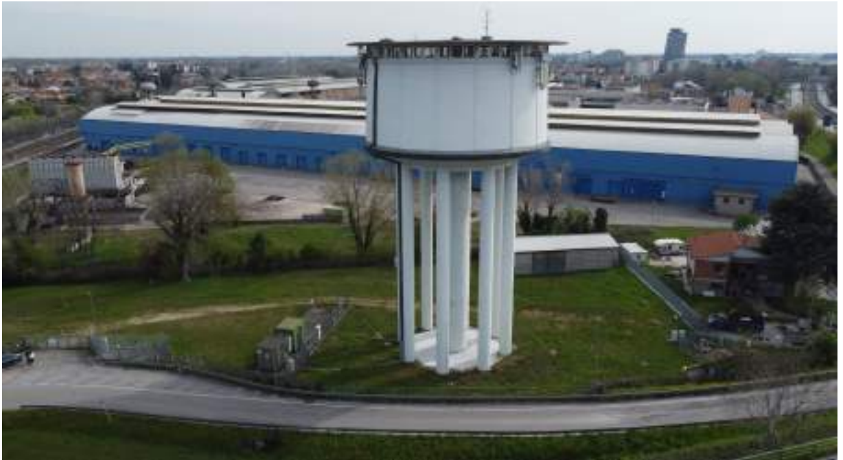
Fig 11_foto con drone del serbatoio orientata verso est.
