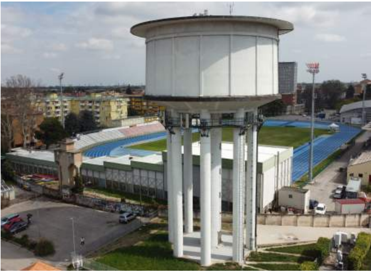
Fig 14_foto con drone del Serbatoio Moroni.
