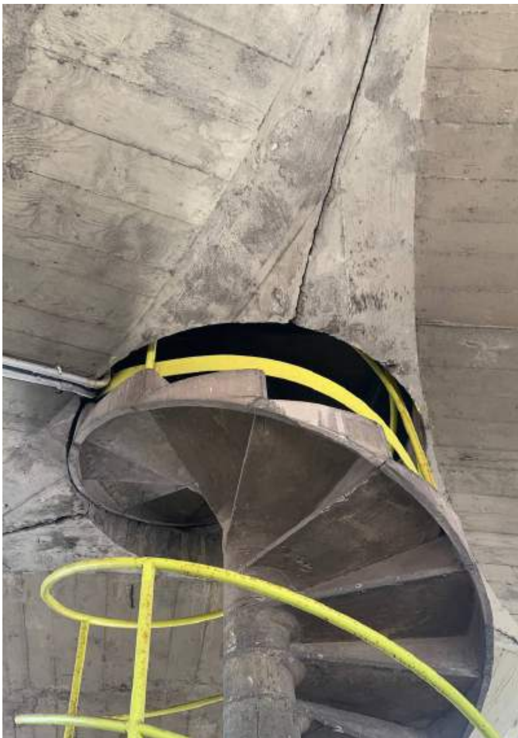
Fig 23_ scala di accesso alle vasche del serbatoio Bottazzo.
