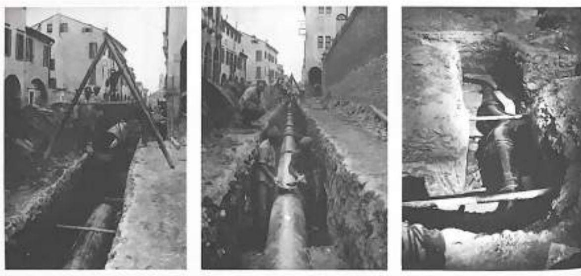
Fig 7_nella pagina a fianco, lavori di ampliamento della rete di distribuzione.
