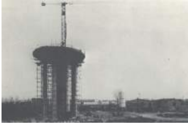
Fig 4_foto storica della costruzione del serbatoio Gramsci.
