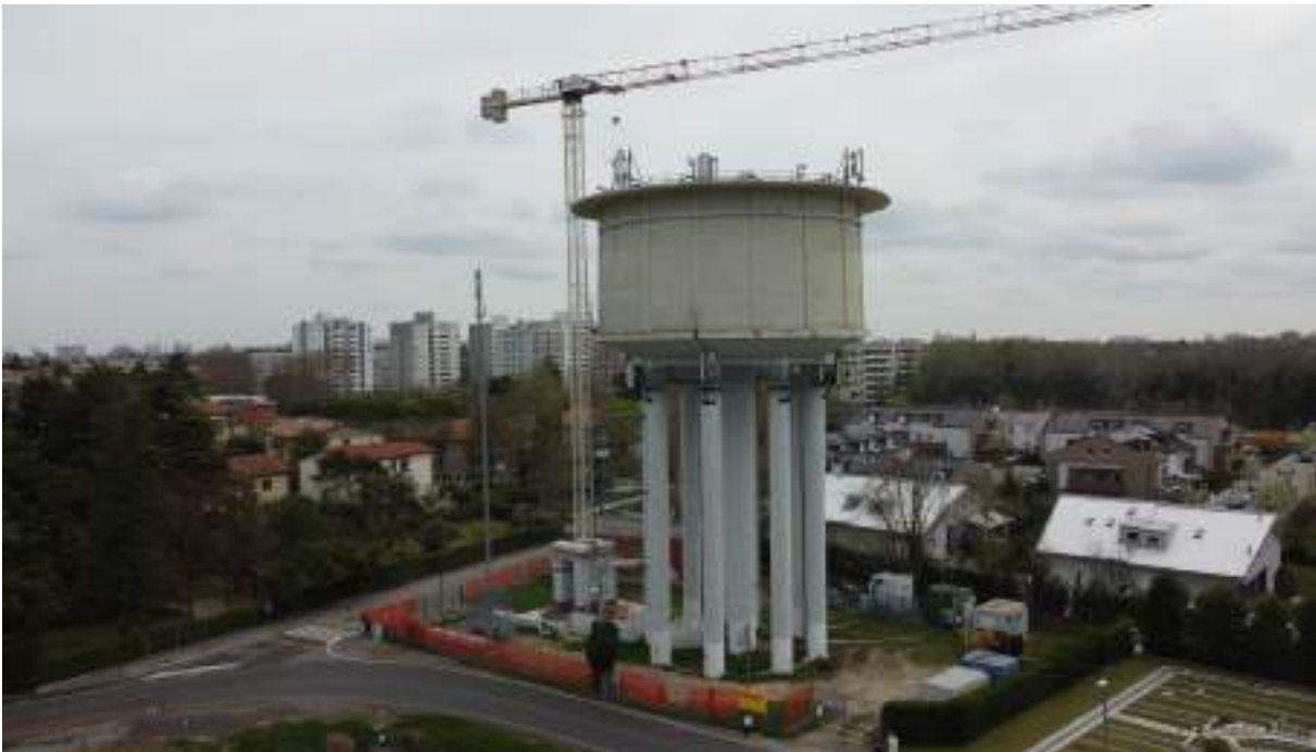
Fig 18_foto con drone del Serbatoio Palermo.
