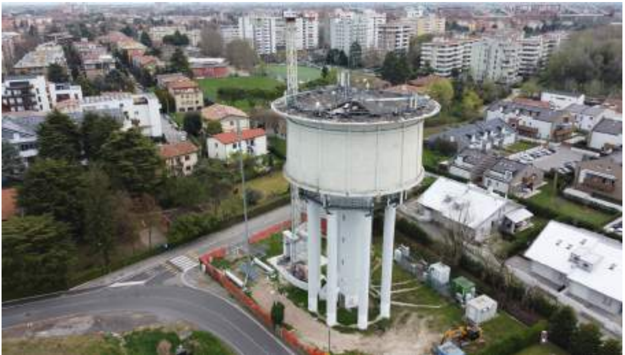
Fig 17_foto con drone del Serbatoio Palermo.
