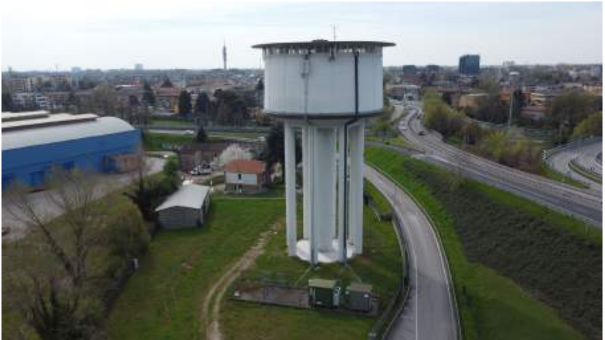
Fig 9_foto con drone del serbatoio orientata verso sud.
