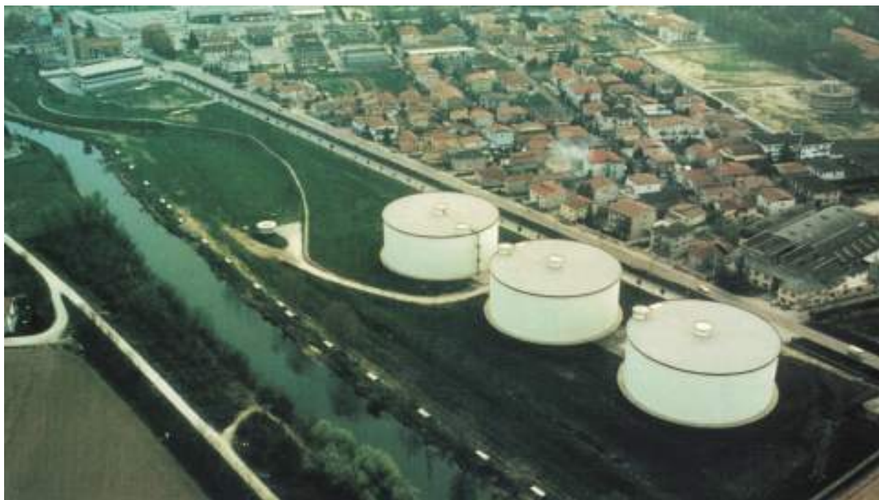
Fig 8_foto aerea del Centro Idrico le Brentelle.
