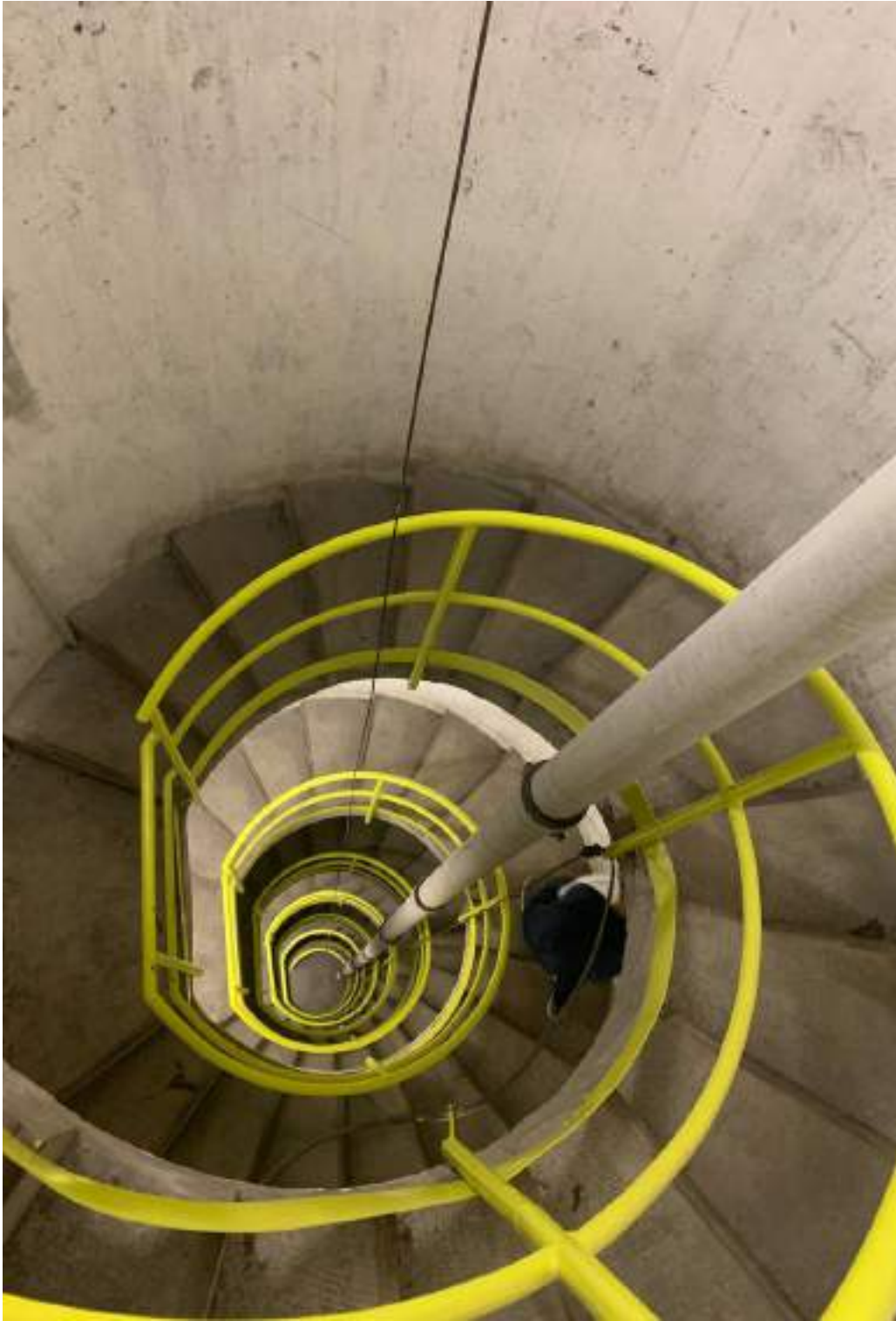
Fig 22_scala interna del serbatoio Bottazzo.
