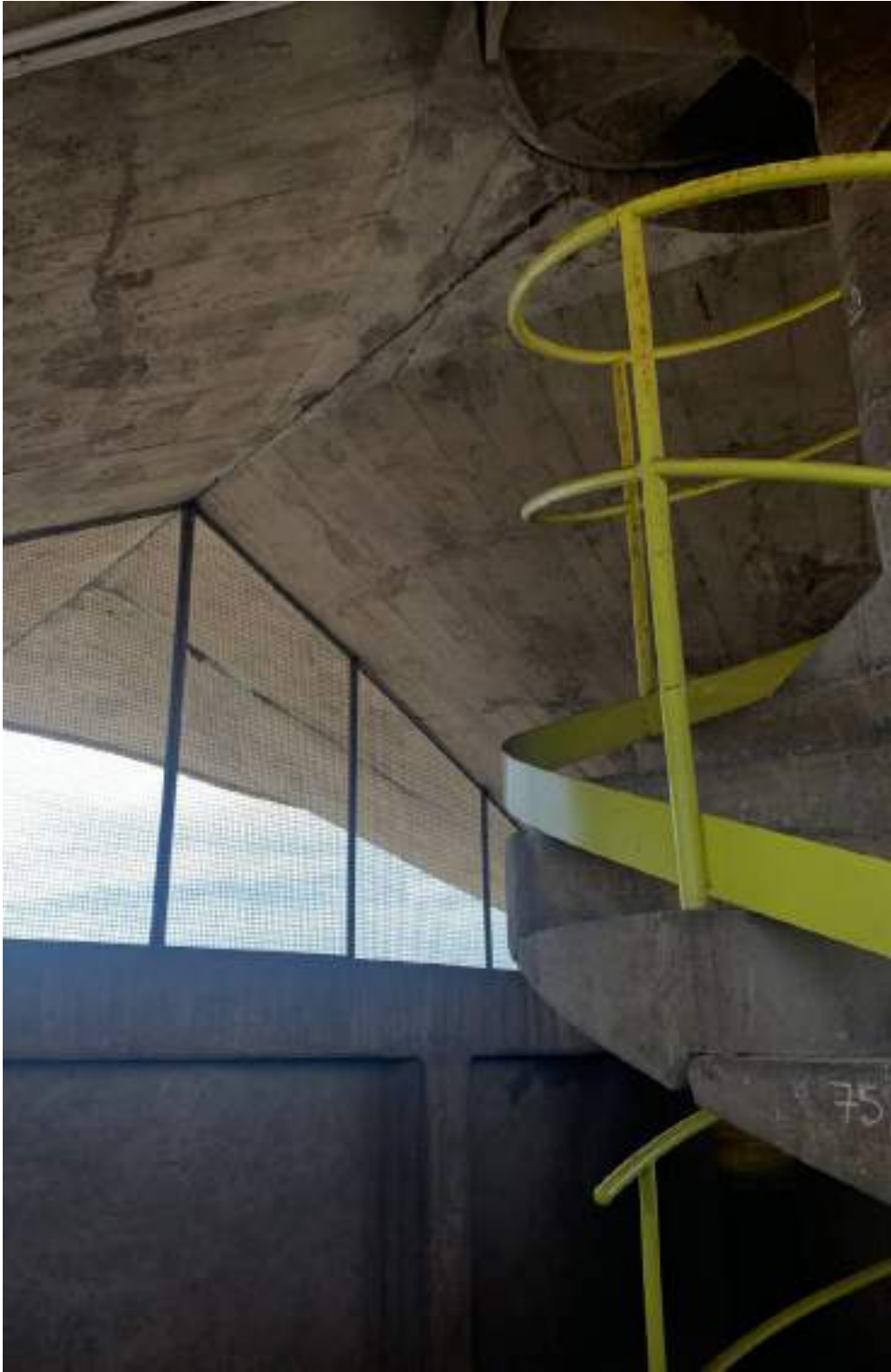
Fig 24_scala di accesso alle vasche del serbatoio Bottazzo dal piano intermedio.
