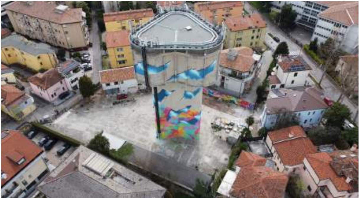
Fig 20_foto con drone del Serbatoio Bottazzo.
