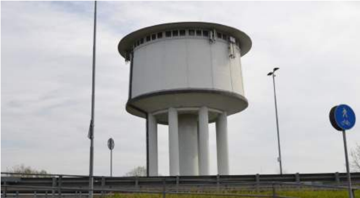
Fig 12_foto del serbatoio da Via Friburgo.
