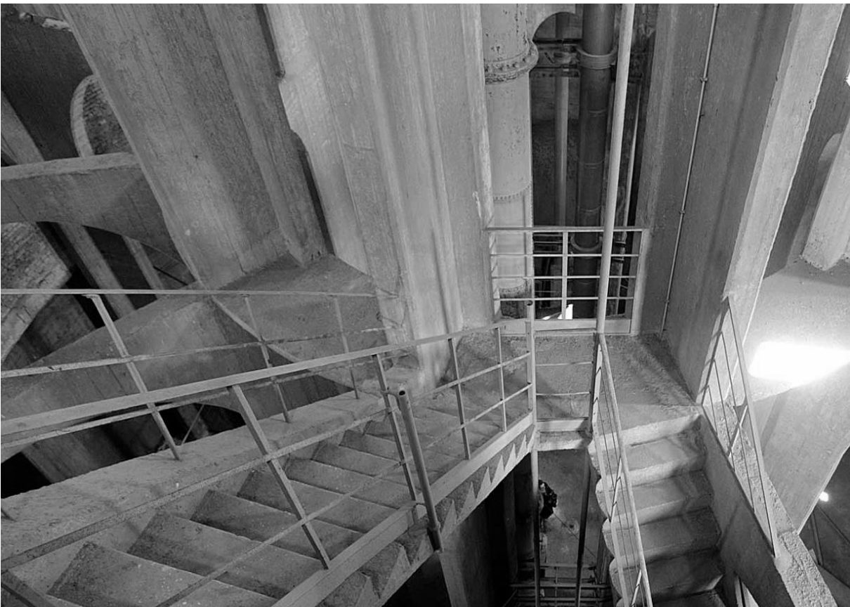
Fig 10_Serbatoio La Rotonda dell'acquedotto di Padova, foto degli interni.
