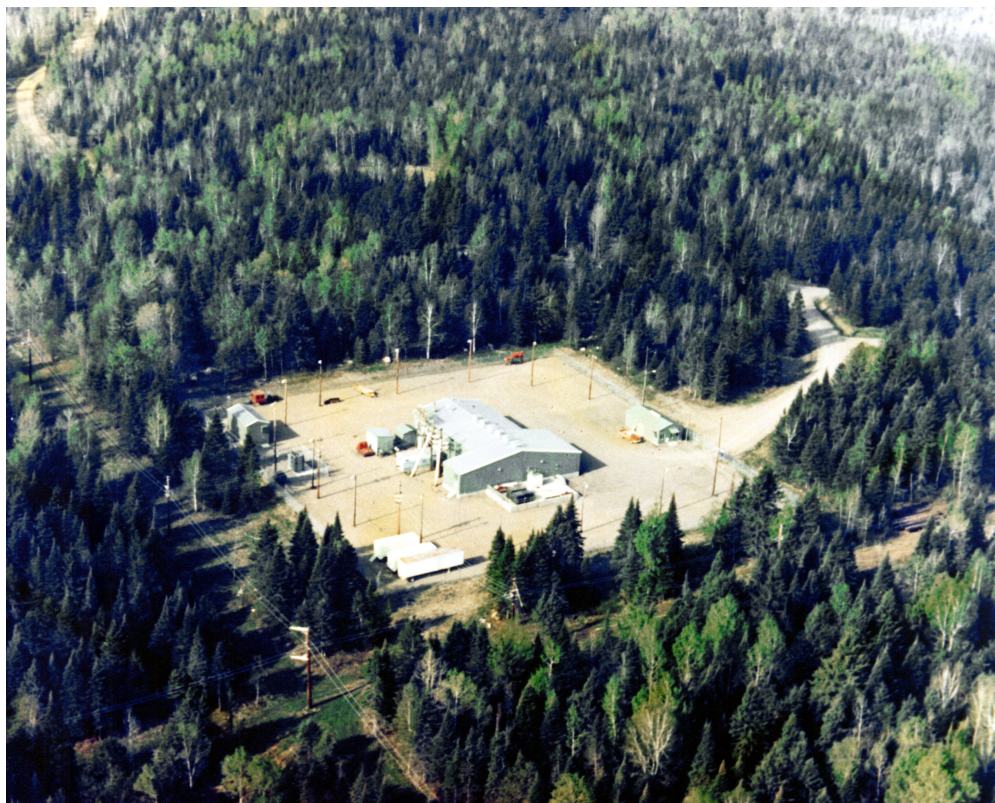
Figura 2.2: Foto aerea della stazione di trasmissione ELF della marina statunitense a Clam Lake, nel Wisconsin. In basso a sinistra si intravede l'inizio dei due bracci del dipolo.
