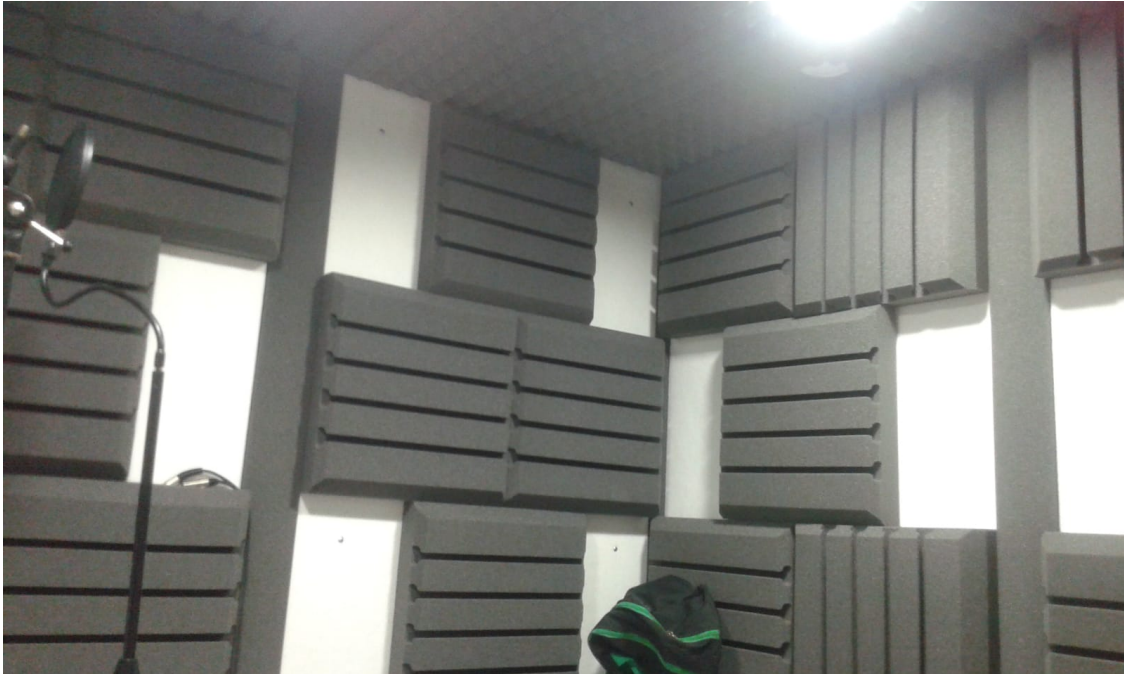
Figura 5.1: Interno della camera silente presente al CSC.
