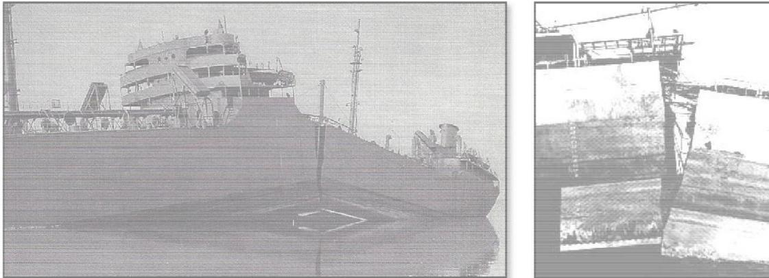
**Fig. 1.1 - Foto delle navi “Liberty” successive alla frattura del ponte**
