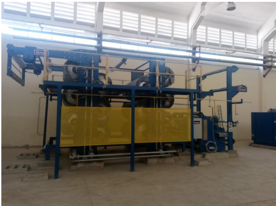
Photo 29 : Machine à essorer et à sécher (Dryer range)
