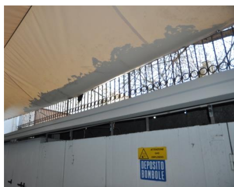
Figura 5.39: Deposito bombole - Cortile interno del corpo D
