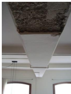
Figura 5.28: Distacco Piano primo - Blocco D
