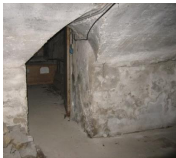
Figura 5.25: Macchie e fronti di risalita Interrato - Corpo D
