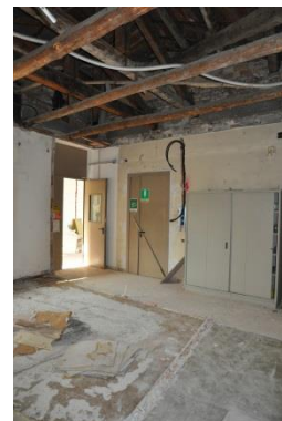
Figura 2.55: Ambiente in fase di ristrutturazione
