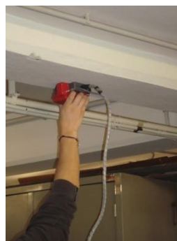
Figura 4.8: Prova con pacometro per valutare le armature in un trave
