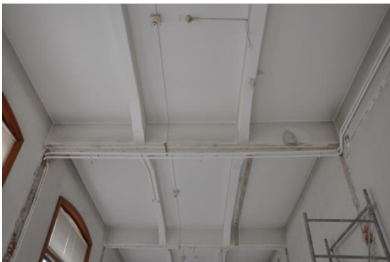
Figura 5.10: Vista del presunto solaio Hennebique
