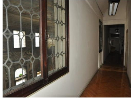
Figura 2.19: Corridoio al secondo piano che si affaccia sul salone principale
