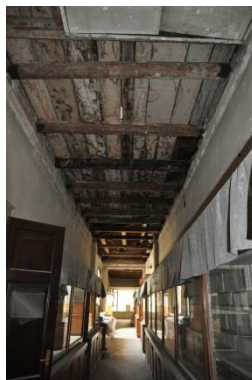
Figura 2.53: Corridoio al secondo piano
