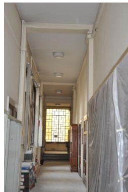
Figura 2.51: Corridoio al primo piano
