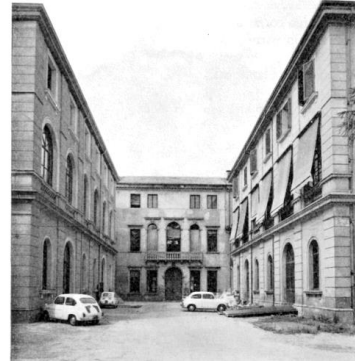
Figura 1.30: Il cortile d'onore dopo le sopraelevazioni
