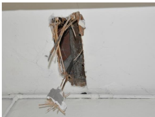
Figura 5.4: Particolare di controsoffitto in camera a canne
