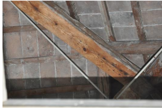
Figura 5.3: Particolare della copertura
