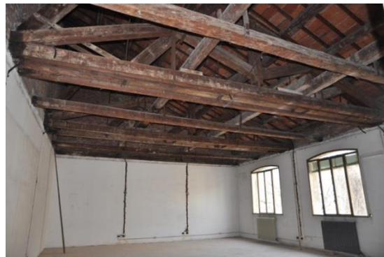
Figura 5.11: Capriate in copertura del corpo D
