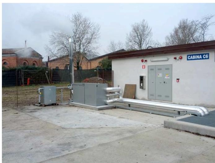
**Figura 6-16:** Caldaia a gas con funzione integrativa
