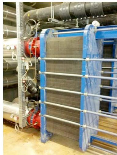
Si portano nella seguente tabella le specifiche tecniche degli scambiatori a piastre che svolgono la funzione principale dell'impianto, ovvero scambiare calore tra l'acqua di laguna ed il fluido termovettore. Come già descritto in precedenza, si tratta di scambiatori in titanio per funzionamento con acqua salmastra (lato laguna) e acqua glicolata (lato impianto), di potenza pari 2.500 kW.
