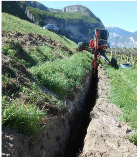
Figura 28 - Escavazione di una trincea per l'installazione di un sistema di DFOS longitudinale, presso l'argine del fiume Adige (Cola et al., 2021).
