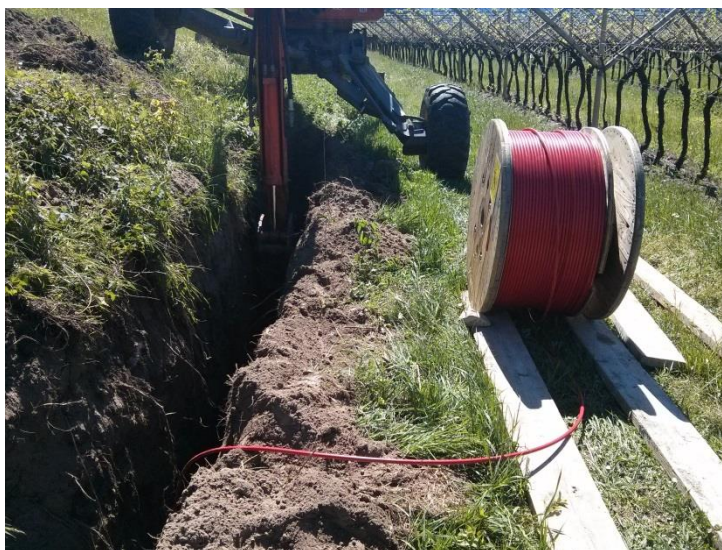
Figura 50 - Installazione del cavo della FO nella trincea
