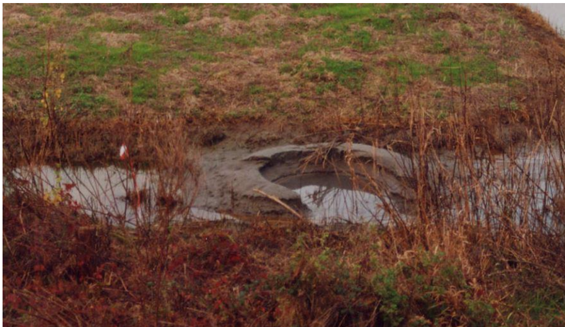
Figura 12 - Tipica forma di fontanazzi formato da liquefazione ed erosione retrogressiva, al piede di un argine (Simonini et al., 2014)
