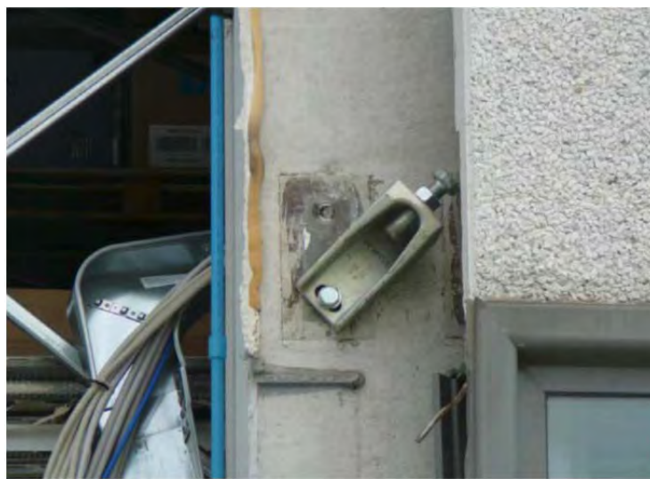
Fig. 17 - Crisi della connessione di un pannello di tamponatura
