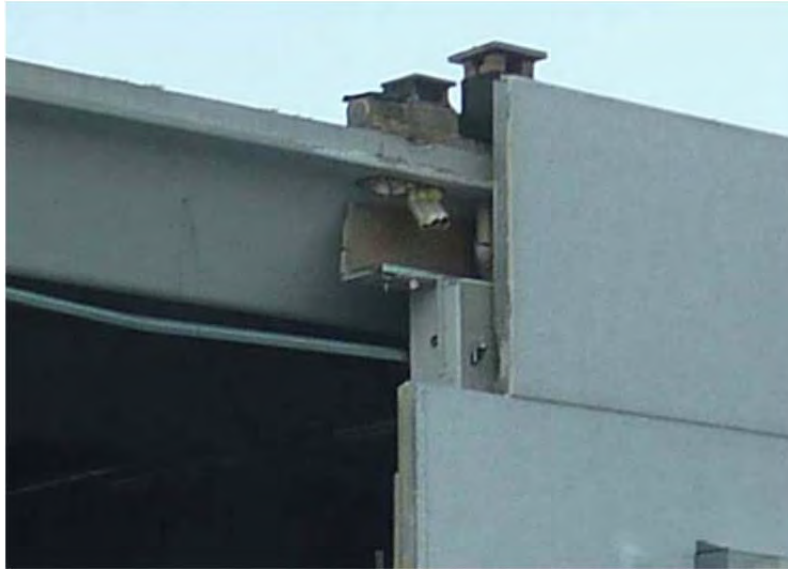
Fig. 21 – Dettaglio della connessione in corrispondenza del pilastro
