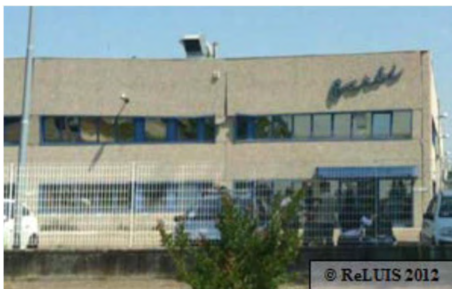
Fig. 18 - Collasso imminente pannelli orizzontali di tamponamento
