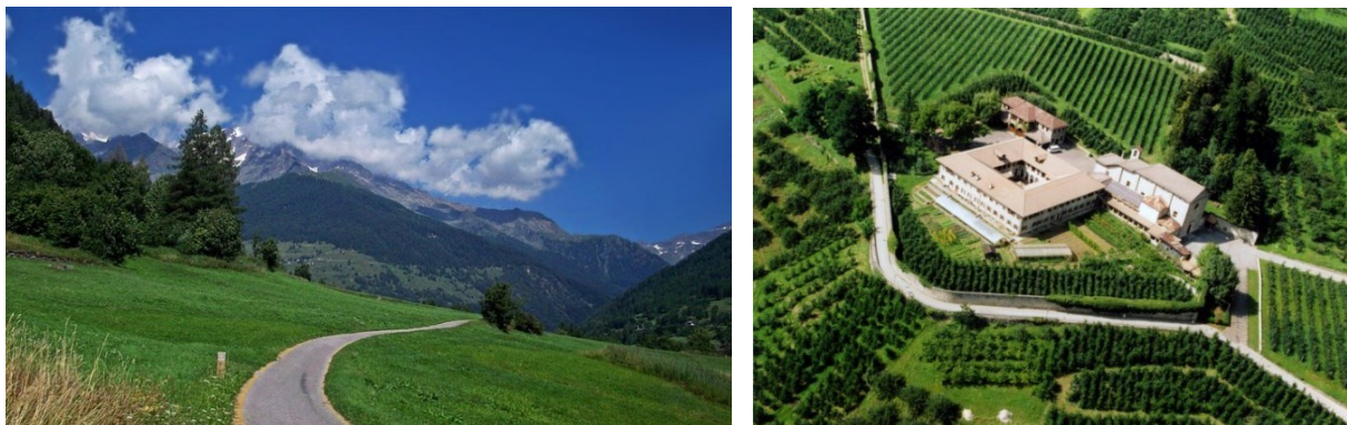
Figura 2.13: Paesaggi rurali della Val di Sole. A sinistra, prati da sfalcio in Val di Pejo; a destra, il Convento dei frati cappuccini di Terzolas, immerso nei meleti. (da Apt, 2023)
