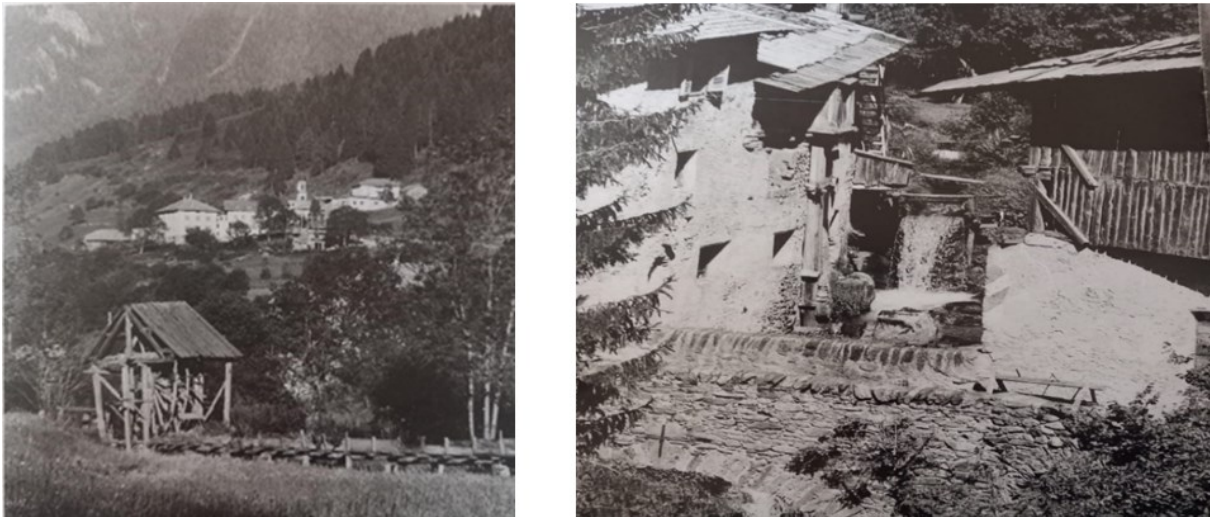
Figura 2.3: Macchine idrauliche in Val di Sole. A sinistra, l'antica noria di Commezzadura, oggi conservata al Museo Etnografico Trentino. A destra, presa dell'acqua sul torrente Rabbies al Pondasio, Malé. (da Faganello, 2000)
