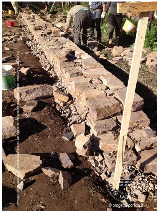
Figura 3.5: Costruzione di un muro a secco in Val di Cembra. La pietra locale, il porfido, è particolarmente adatto alla costruzione di muri. (Foto: www.porfido.me )
