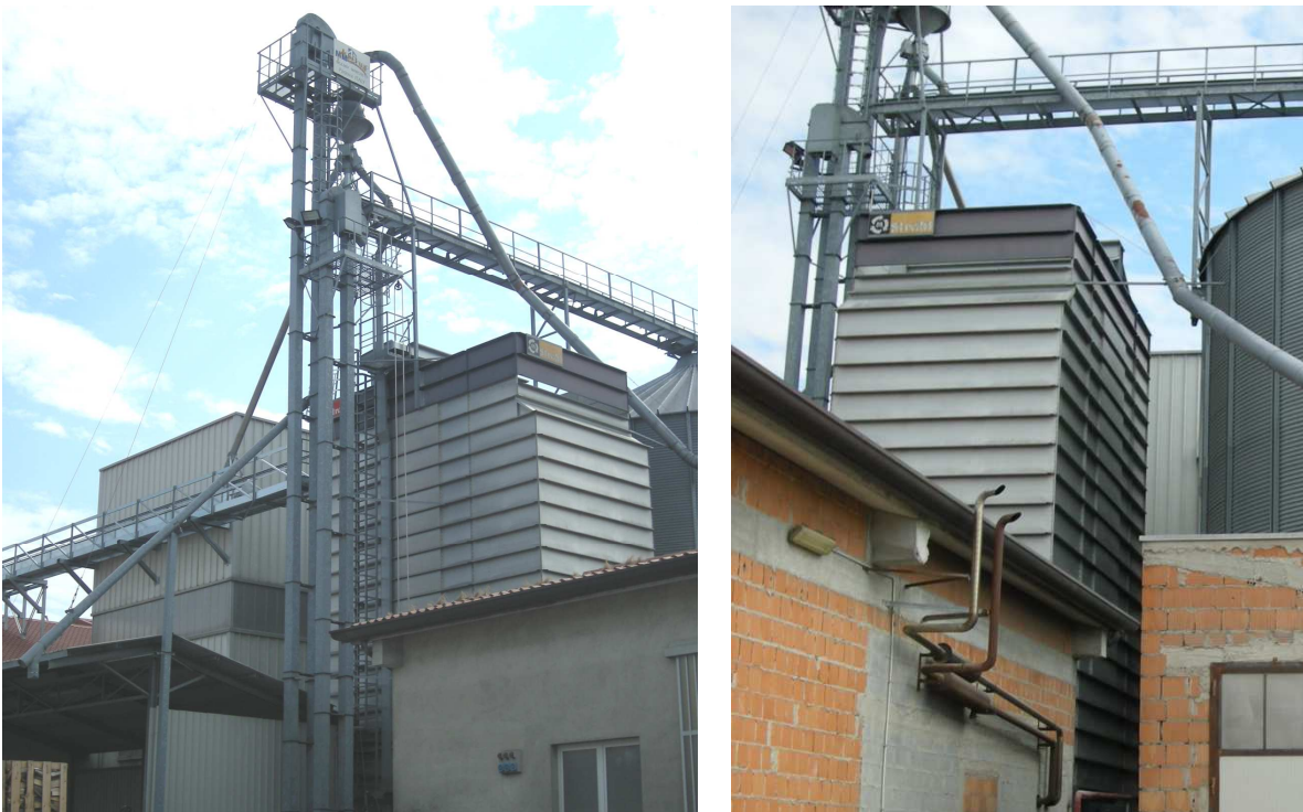
Figura 86 e 87: L'area dove è stato eretto l'impianto di essiccazione
