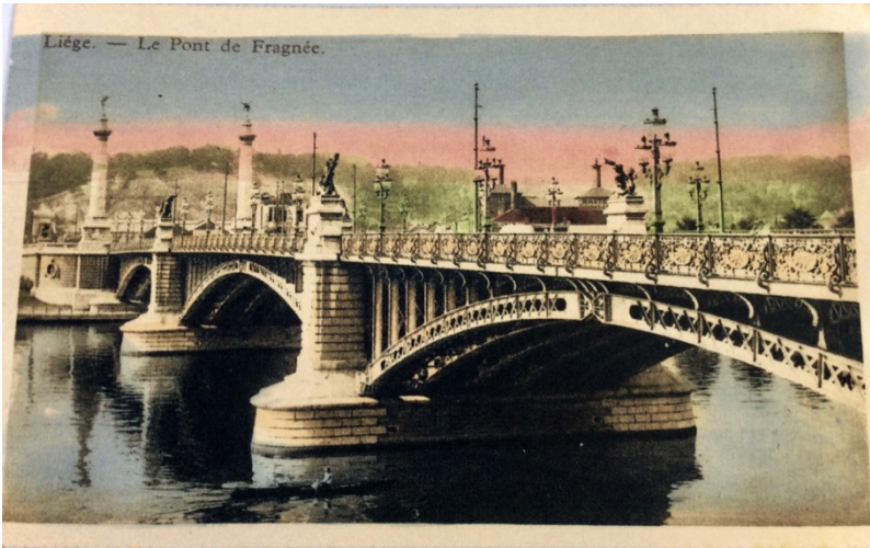
Figure 16 : Le Pont de Fragnée sous les travaux du roi Léopold III (159)
