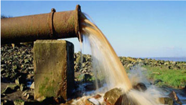
Figura 12: Scarico di acque reflue industriali direttamente in un corso d'acqua
