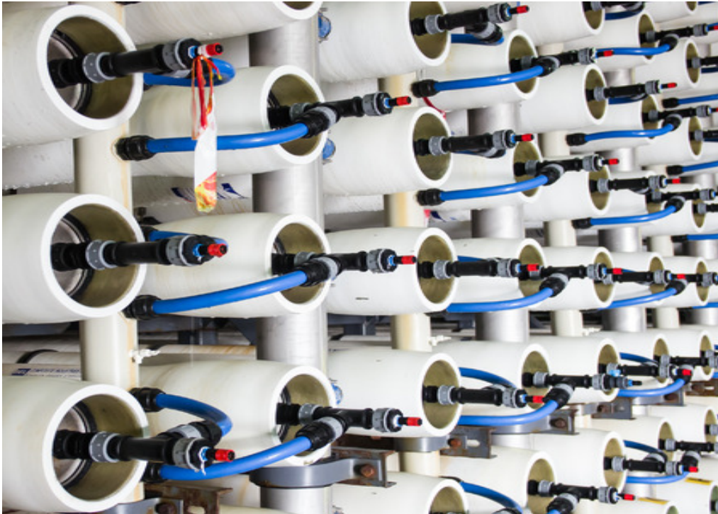
Figura 2: Impianto di desalinizzazione funzionante ad osmosi inversa.
