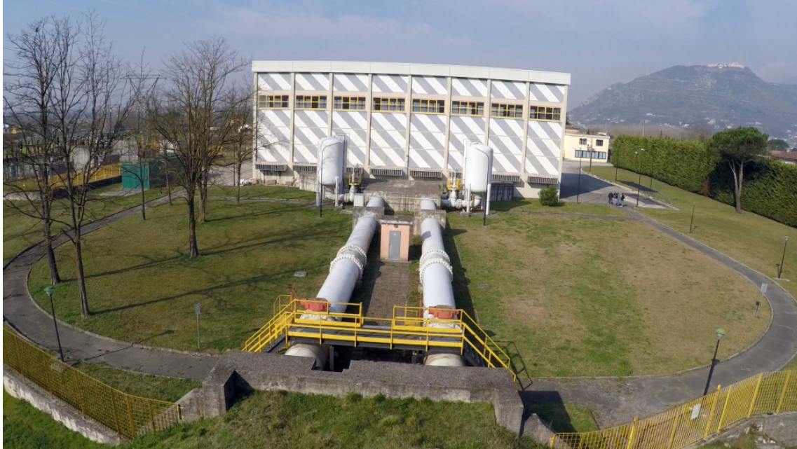
Figura 2: Esempio di centrale di sollevamento vista dall'esterno.
