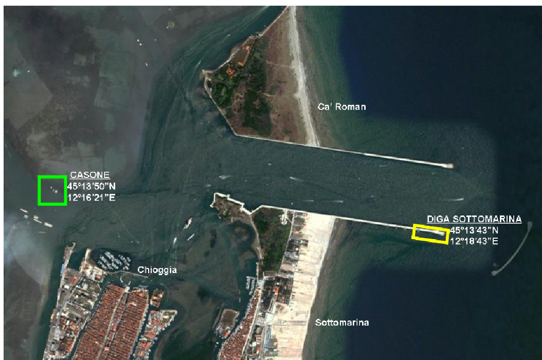
Figura 3. Foto aerea della bocca di porto di Chioggia, in cui sono visibili le due aree di raccolta degli animali.
