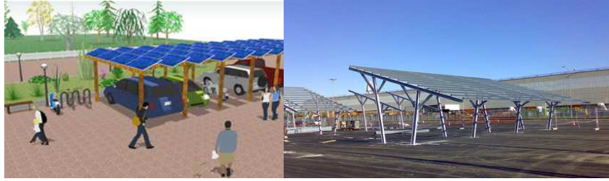
Figura 11: Integrazione architettonica dei pannelli nella copertura dei parcheggi
