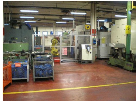
Figura 6.11 – Area destinata alla nuova macchina
