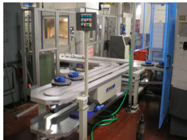
Figura 6.13 – Nastro portapallet in fase di installazione
