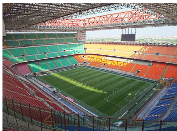
San Siro con copertura completa
