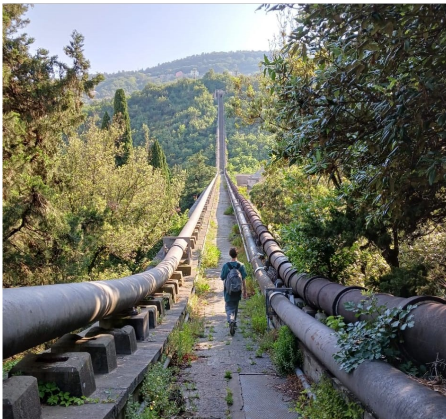
Figura 4 - Ponte Sifone sul rio Veilino - Acquedotto Storico di Genova; Fonte: foto dell'autore, 2023.
