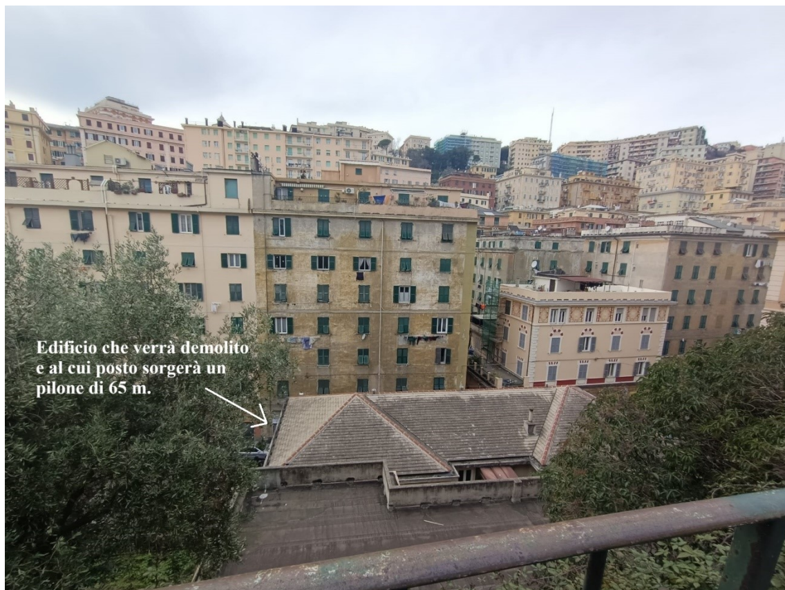
Figura 19 - Via avezzana, area in cui verrà costruito il primo pilone; Fonte: foto dell'autore, 2024
