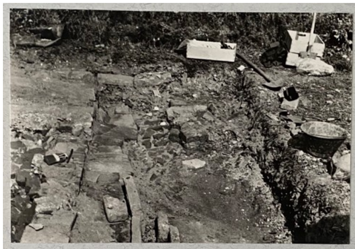
Fig. 58 - Settore meridionale della trincea 8. Strato II visto da Ovest. Fotografia del 1979, dall'archivio del Museo Archeologico Nazionale di Adria.
