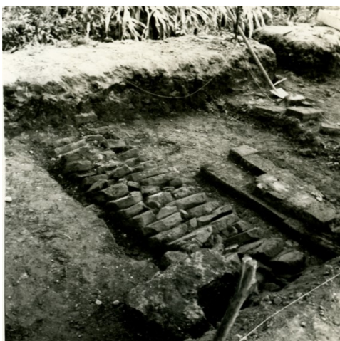
Fig. 43 - Fotografia in cui si vede la fondazione di un muro realizzata in mattoni posti di taglio. Fotografia del 1977, dall'archivio del Museo Archeologico Nazionale di Adria.
