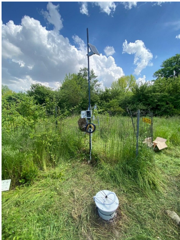
Figura 5.5.1: Stazione di monitoraggio installata nel pozzo Milano 1.
