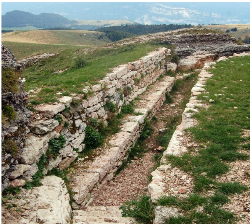
Fig. 2.19 – Una delle trincee che si collega all'ex ridotto difensivo presso Malga Pidocchio.
