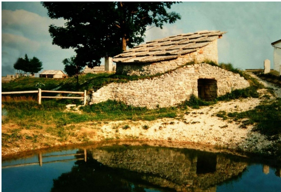
Fig. 2.16 – La “Giassara del Grietz” vista dall’esterno, con la pozza annessa.
