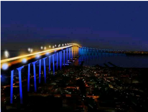
Figura 2.5: ponte di San Diego illuminato con i LED
