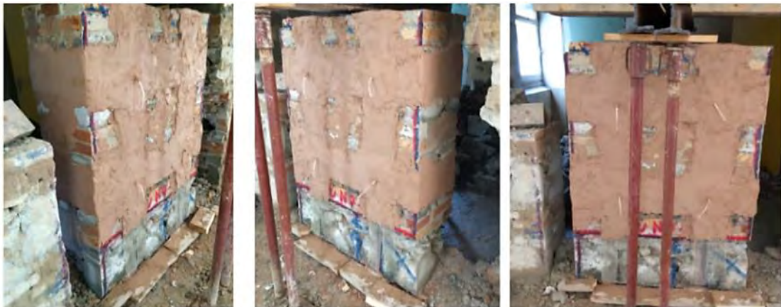
Figura 110 – Disposizione del rinforzo
