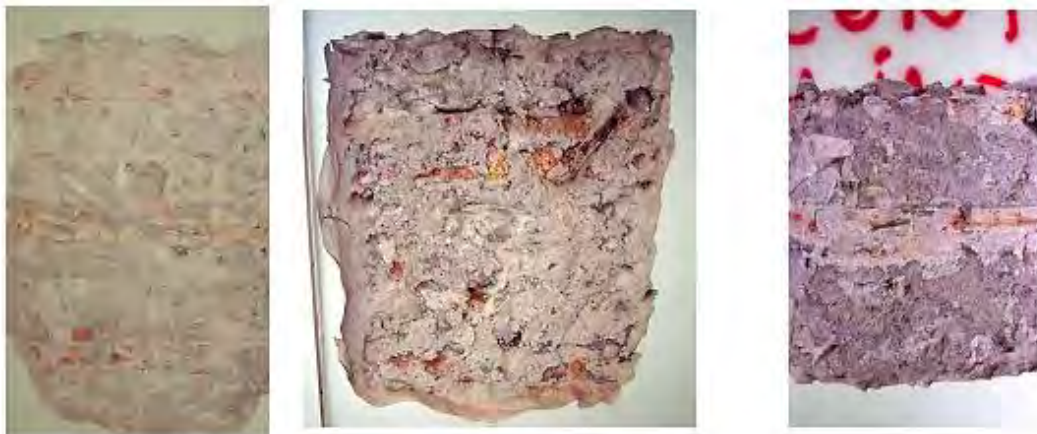
Figura 98 – Saggi di muratura corpo A1
