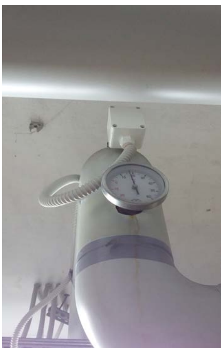
Figura 2.10 Sopra al termometro analogico è possibile vedere una sonda a pozzetto nel relativo alloggiamento. Questo tipo di sonde garantisce una rilevazione della temperatura molto più precisa delle sonde a collare.
