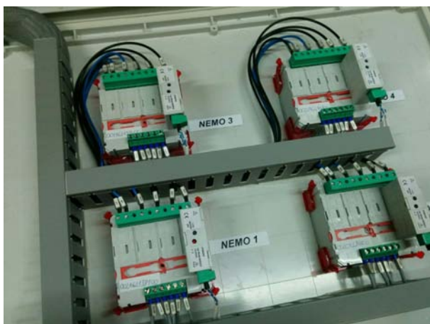
Figura2.4 Vista posteriore dei quattro dispositivi NEMO HD96+ con modulo di comunicazione LON.
