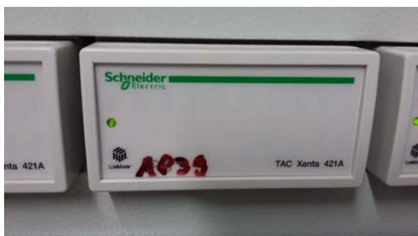
Figura 2.16 Dispositivo TAC Xenta 421A per il riconoscimento dello stato degli interruttori dotato di 4 relè di uscita per invio del segnale di ripristino. Protocollo dati LonWorks.
