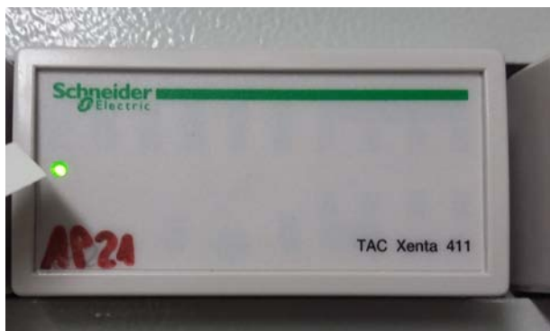
Figura 2.15 Dispositivo per il riconoscimento dello stato degli interruttori TAC Xenta 411. Protocollo dati Modbus.
