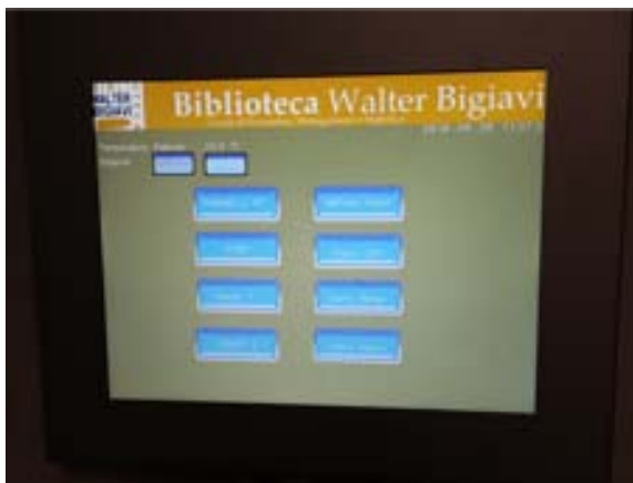
Figura 2.14 Pannello touchscreen LOITECH per il controllo locale dell'impianto
