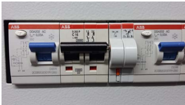
Figura 2.18 Interruttore bipolare ABB dotato di servomotore per il telecontrollo.
