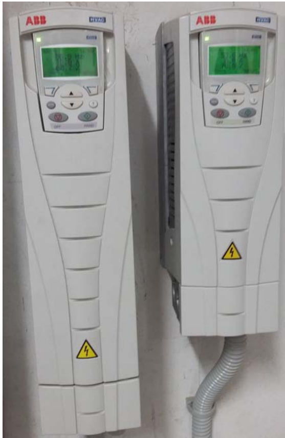
Figura 2.12 Inverter per il controllo dei motori dell'UTA.
