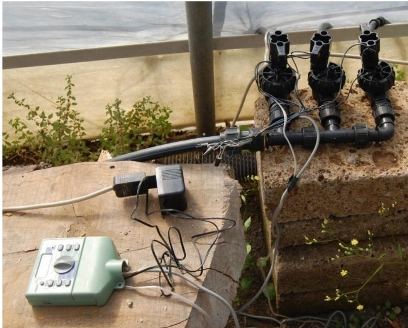
Fig.75- Visione d'insieme della centralina e delle elettrovalvole.
