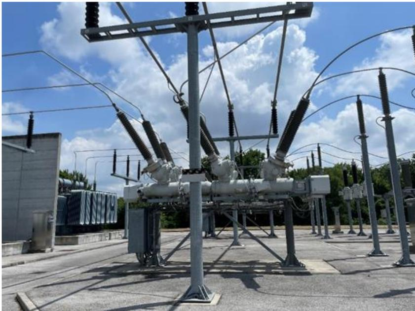
Le GIS sono sottostazioni elettriche in cui le apparecchiature per la trasmissione e la distribuzione dell'energia sono racchiuse in un involucro metallico chiuso, messo a terra e riempito di gas isolante, solitamente l'esafluoruro di zolfo ( $\text{SF}_6$ ).
