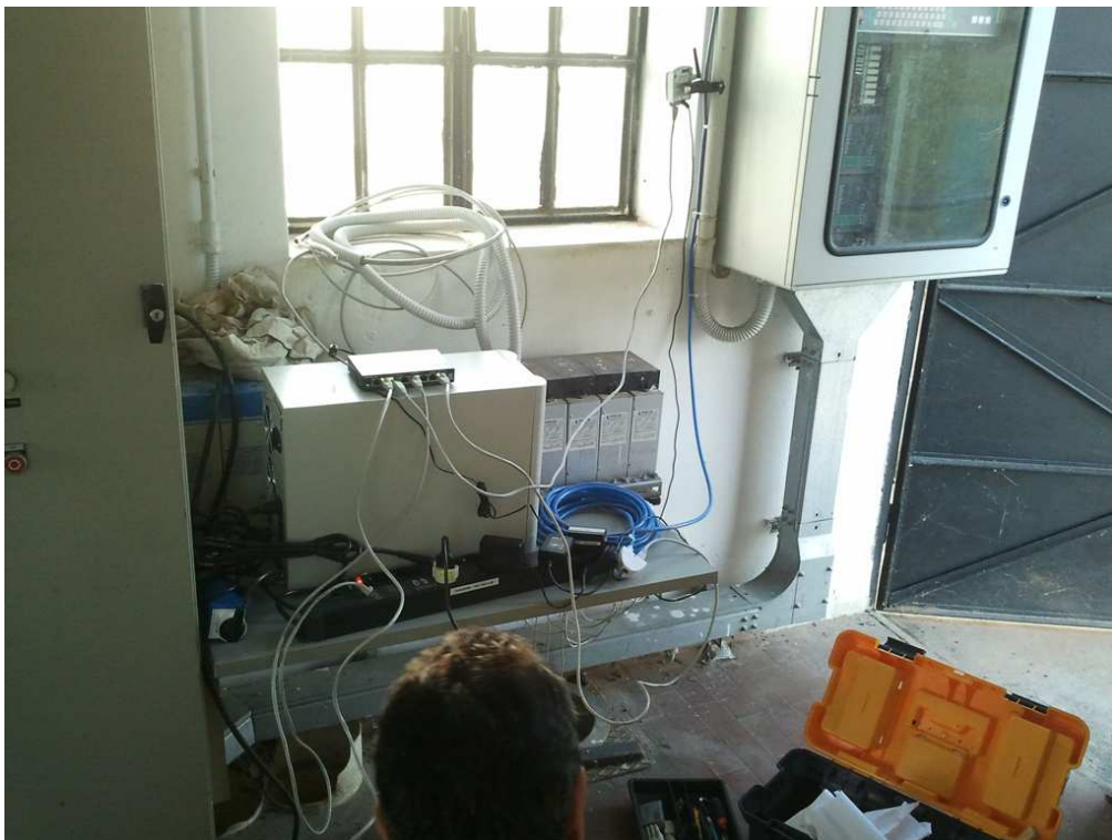
Figura 3.2: Apparecchiatura in fase di montaggio alla Sacca del Canarin
