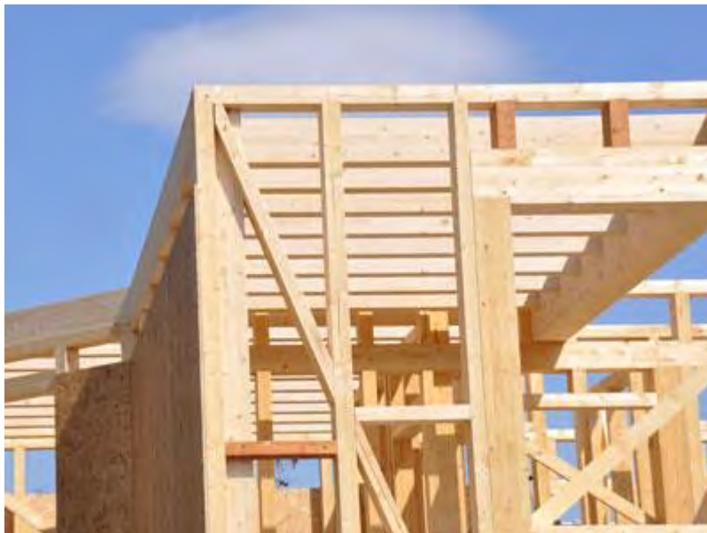
Figura 4.66: Sistema costruttivo plat-form frame.
