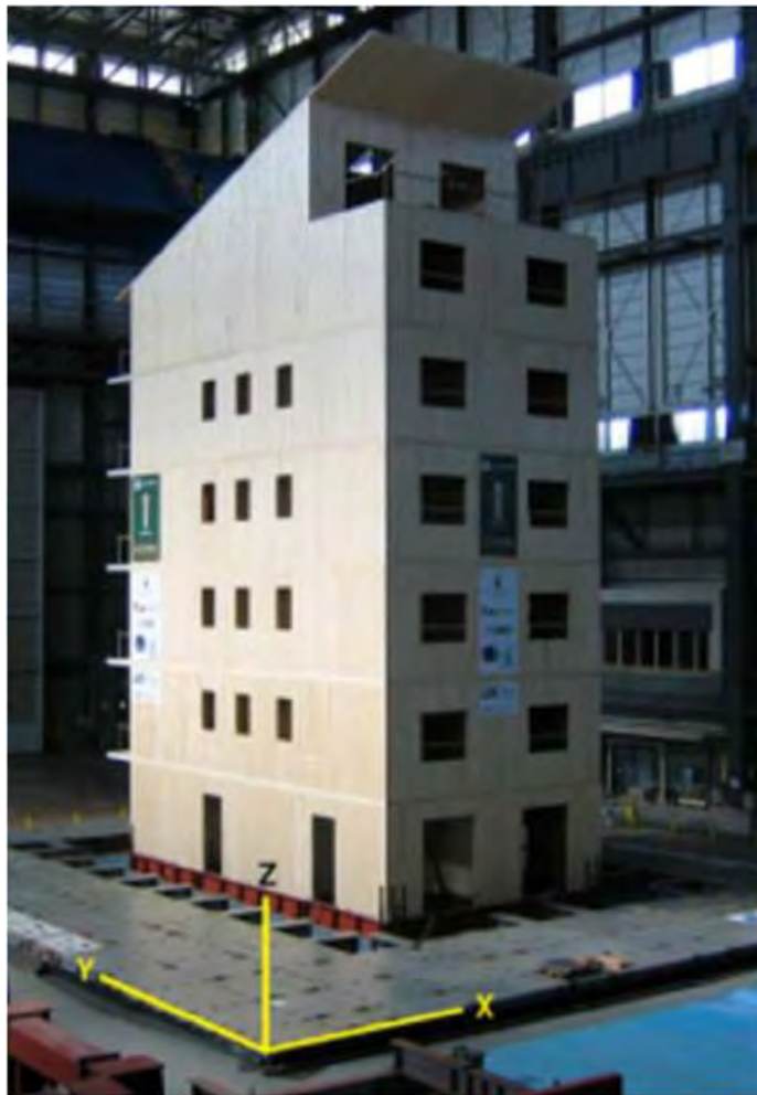
Figura 2.5: Edificio SOFIE 7 piani per test sismico a Mikia. Immagine tratta da "SOFIE project: 3D shaking table test on a seven-storey full-scale cross-laminated timber building" Ario Ceccotti et al.
