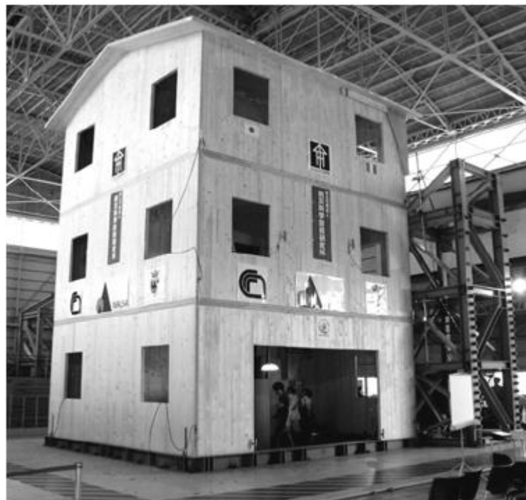
Figura 2.3: Edificio SOFIE 3 piani per test sismico a Tsukuba. Immagine tratta da "Comportamento sismico di edifici in X-Lam: il progetto SOFIE" Ario Ceccotti.
