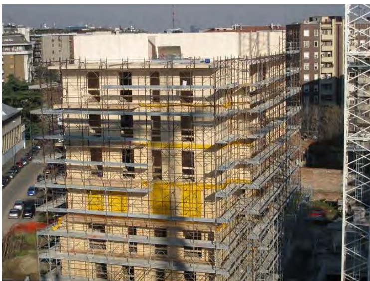
Figura 2.47: Fase costruttiva del complesso Cenni di cambiamento Milano.
