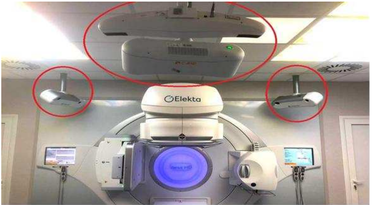
Figura 3 Catalyst ( in rosso) in sala di trattamento
