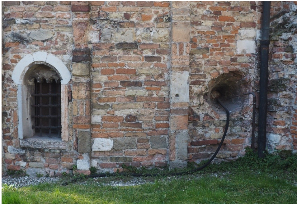
Fig. 83, Veduta del lato nord dell'abside della chiesa dei Santi Felice e Fortunato di Vicenza. Sono visibili l'oculo nord, riaperto nel 1935 e della seconda finestra voluta dall'abate Albertus, (© Giada Cattani).
