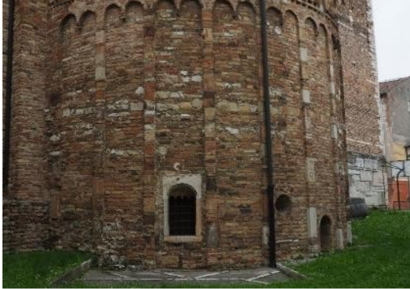
Fig. 82, Veduta sud-est dell'attuale dell'abside della chiesa dei Santi Felice e Fortunato, (© Giada Cattani). Si vedono la finestra centinata voluta dall'abate Albertus a sinistra, l'oculo che si apre a sud-est aperto nel 1937.
