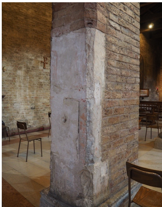
Fig. 92, Veduta, allo stato attuale, del terzo pilastro di sinistra della chiesa dei Santi Felice e Fortunato, di cui si vede il lato originario, in pietra bianca, (© Giada Cattani).
