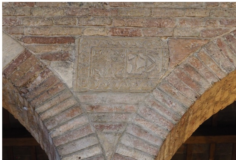
Fig. 71, Frammento di pluteo longobardo sopra il terzo sostegno di sinistra della chiesa dei Santi Felice e Fortunato di Vicenza, (© Giada Cattani).
