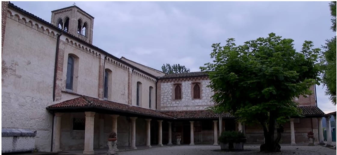
Fig. 158, Dettaglio del chiostro novecentesco della chiesa di Sant'Agostino di Vicenza, (© Giada Cattani).
