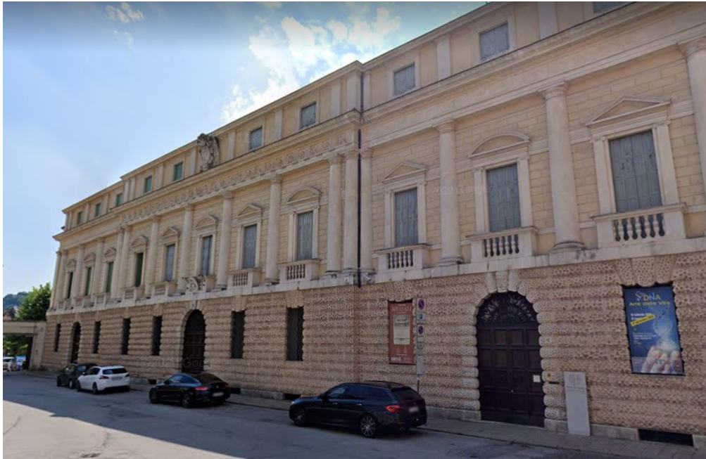
Fig. 153, Palazzo Vescovile di Vicenza, come lo si vede oggi, ricostruito dopo la Seconda Guerra Mondiale. Si nota il piano attico aggiunto durante la ricostruzione, (© Giada Cattani).
