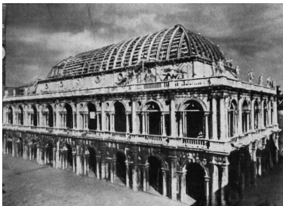
Fig. 151, La Basilica Palladiana di Vicenza durante i lavori di restauro dopo la Seconda Guerra Mondiale. La foto è tratta da: FERDINANDO FORLATI, Restauro di edifici danneggiati dalla guerra, provincia di Vicenza , in «Bollettino d'arte», cit., p. 266.
