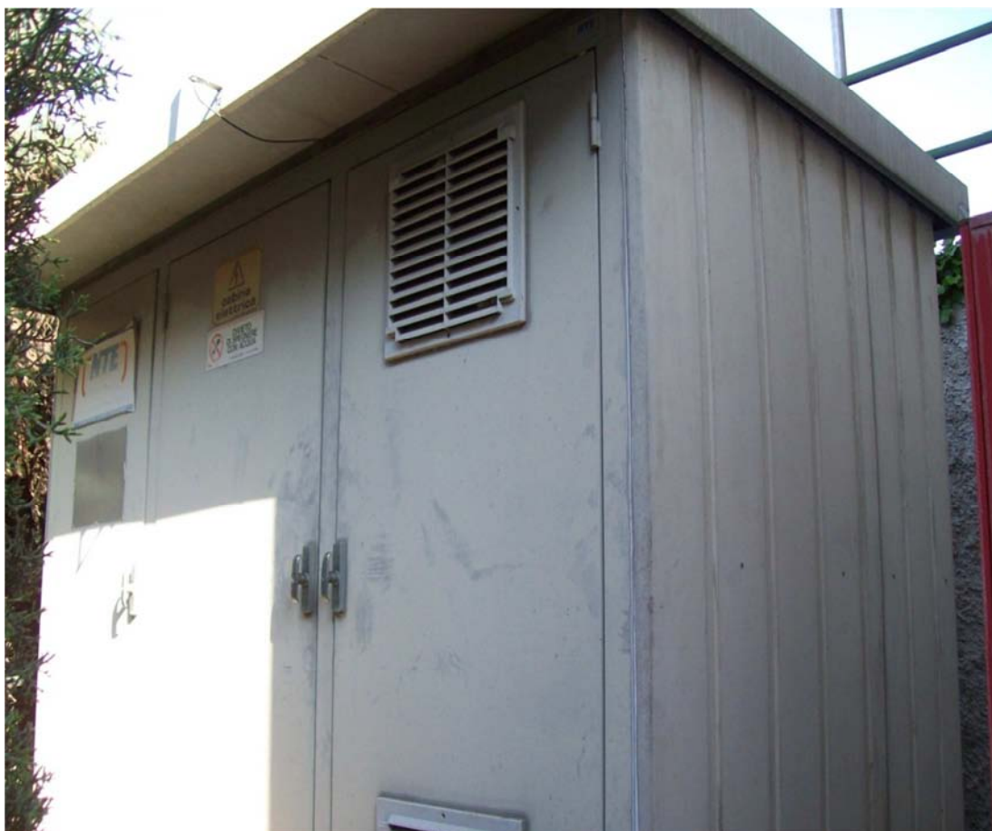
Figura 31: Foto che ritrae il box prefabbricato della cabina Casa Betania.
