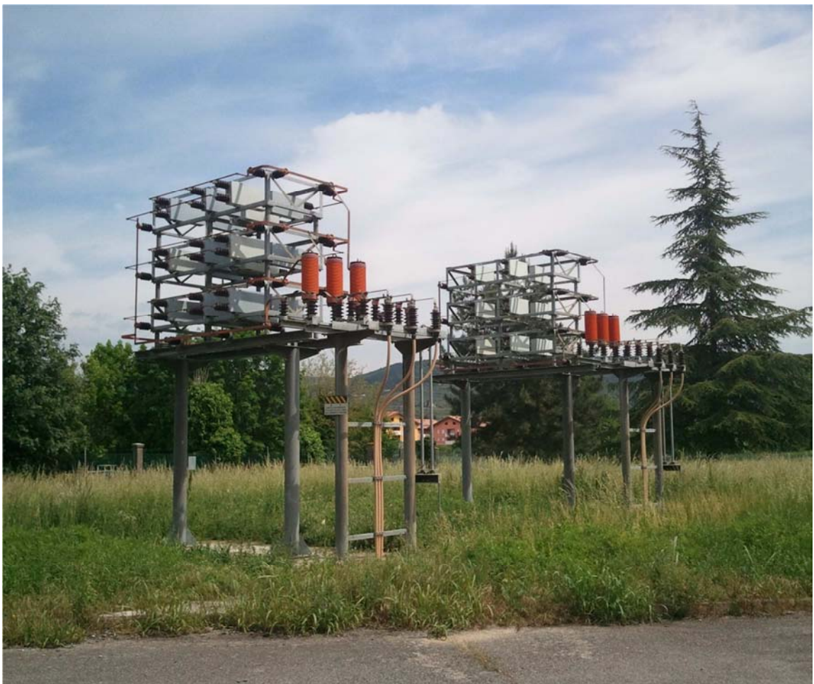
Figura 14: Foto dei banchi di condensatori presenti nella CP Ricevitrice Est.
