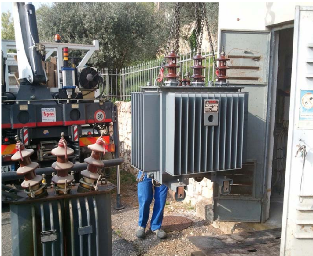
Figura 29: Foto realizzata al momento della sostituzione del trasformatore. A sinistra, si intravede il vecchio Tr da 63kVA portato fuori dalla cabina; a destra attaccato alle catene della gru, quello nuovo da 250kVA.
