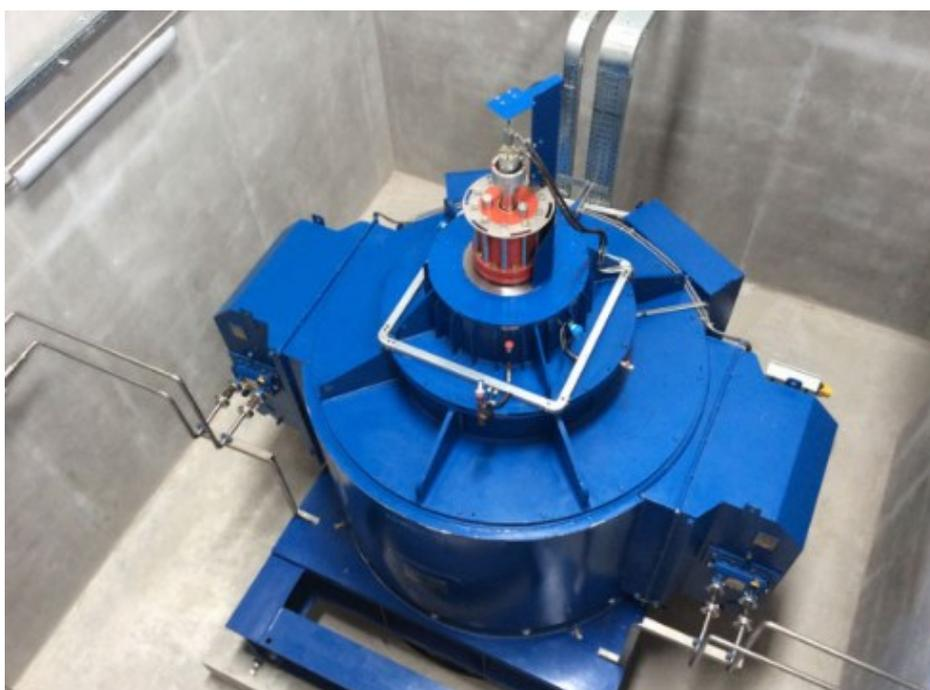
**Figura 26.** *Generatore sincrono della centrale idroelettrica*
