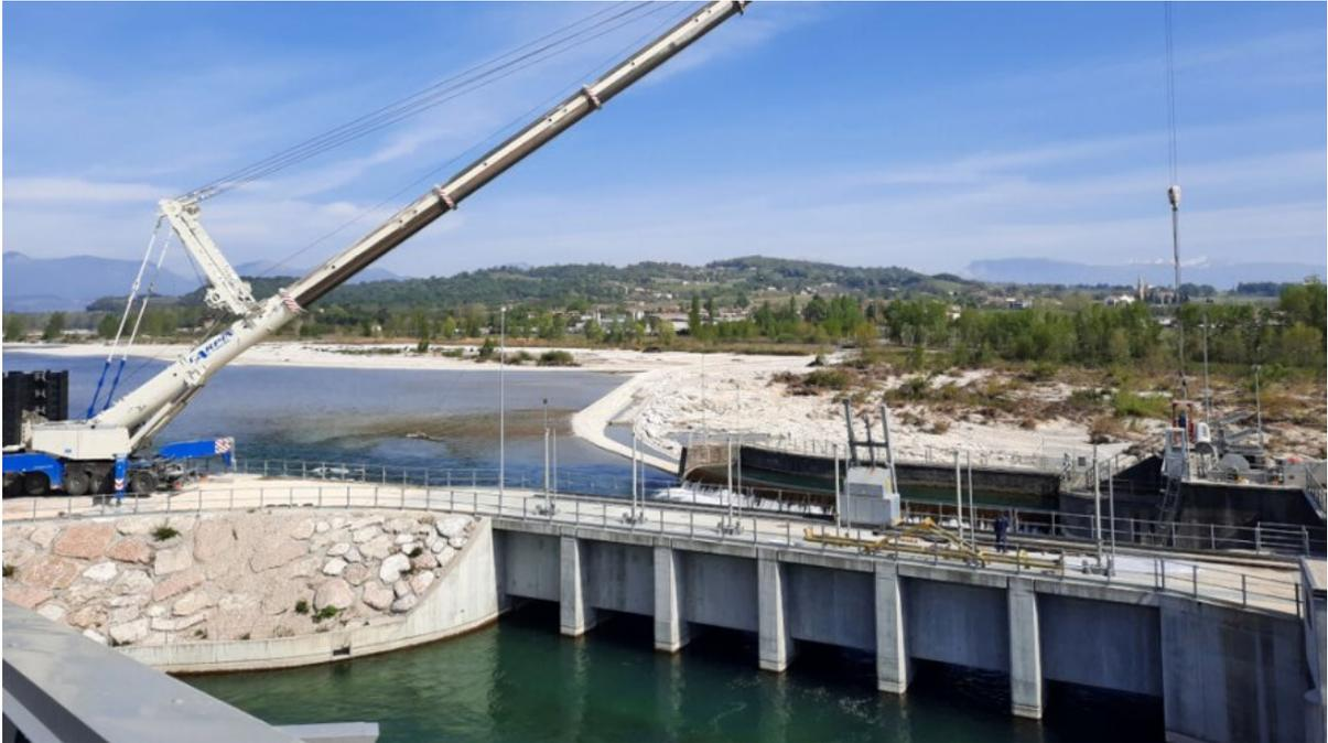
**Figura 31.** *Lavori di sostituzione della paratoia Galileo*
