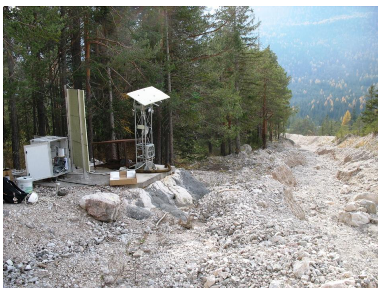
Fig. 3.7 - Posizione della stazione di valle rispetto al canale, 2 novembre 2017
