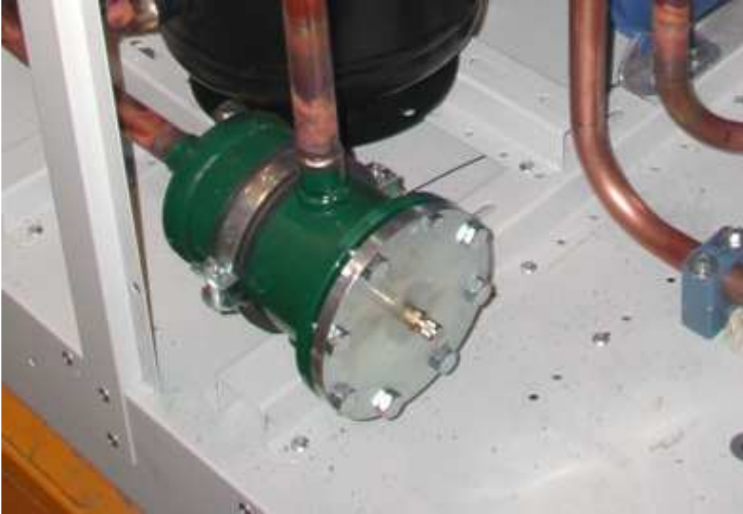
Figura 6-23: Filtro disidratatore CASTEL
