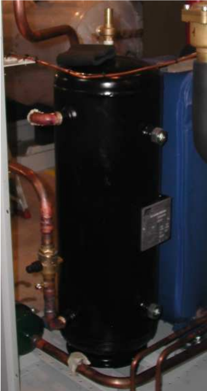
Figura 6-27: Ricevitore di liquido Frigomec.
