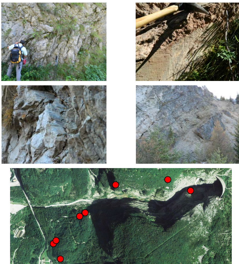
Fig. 35 Rilevamento di terreno sulle strutture fragili sulla sinistra idrografica del torrente Vajont.
