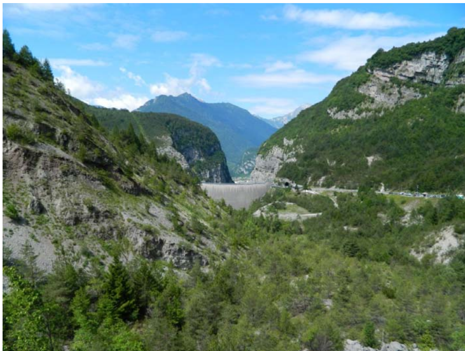
Fig. 25 Immagine della diga del Vajont, vista dal lato di Erto e Casso.
