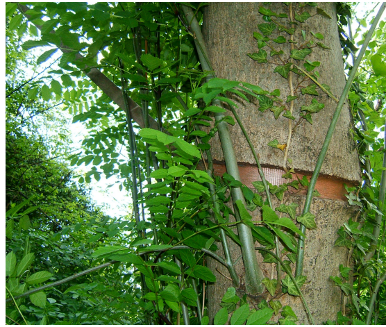
Figura 3.6 tronco utilizzato come ancoraggio per la torretta
