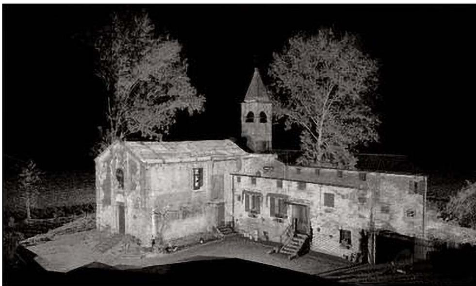
**Figura 3.9:** Rilievo tridimensionale della chiesetta di Ca' Murà con attigua casetta. Sia la casa che la chiesetta sono rialzate dal livello del suolo circostante, probabilmente per isolarle dal suolo.
