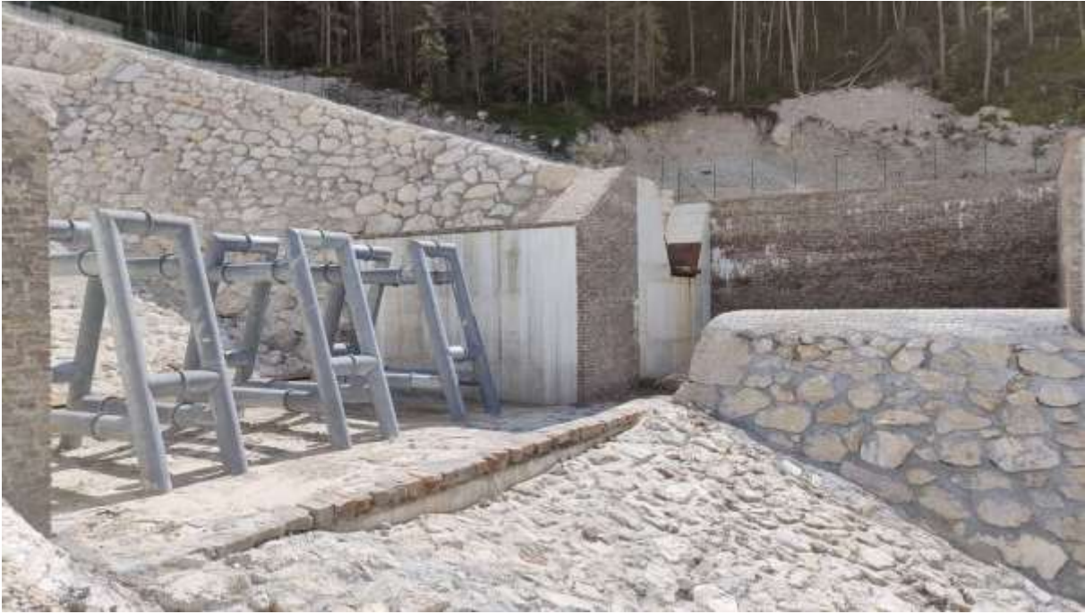
Figura 21. Vista laterale dell'intervento di sistemazione (Il notiziario di Cortina)
