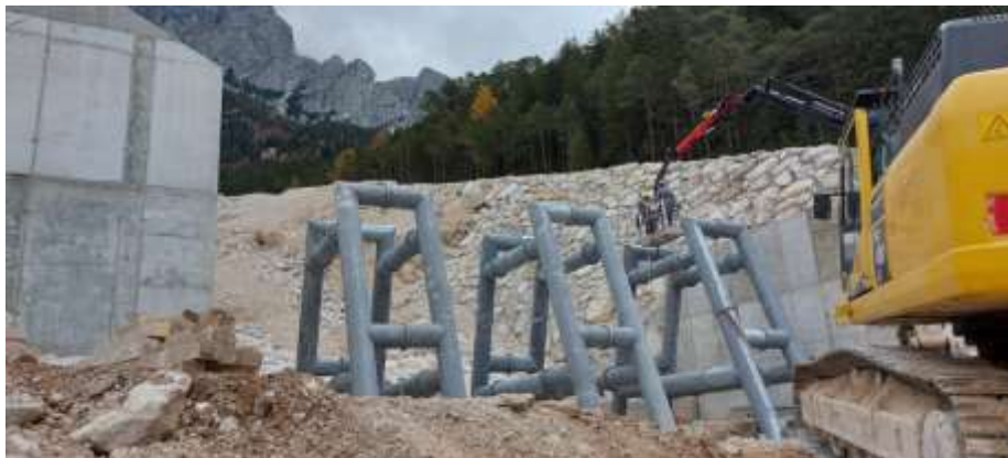
Figura 16. Briglia frangicolata Sabo dam installata all'interno del Canale di Rovina di Cancia
