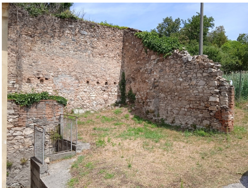
Figura 16 Resti del Mulino di Via Pilastrì Rossi presso Valnogaredo. In basso a sinistra, scorreva ancora dell'acqua in un calto sotterraneo (foto dell'autore, 2022)
