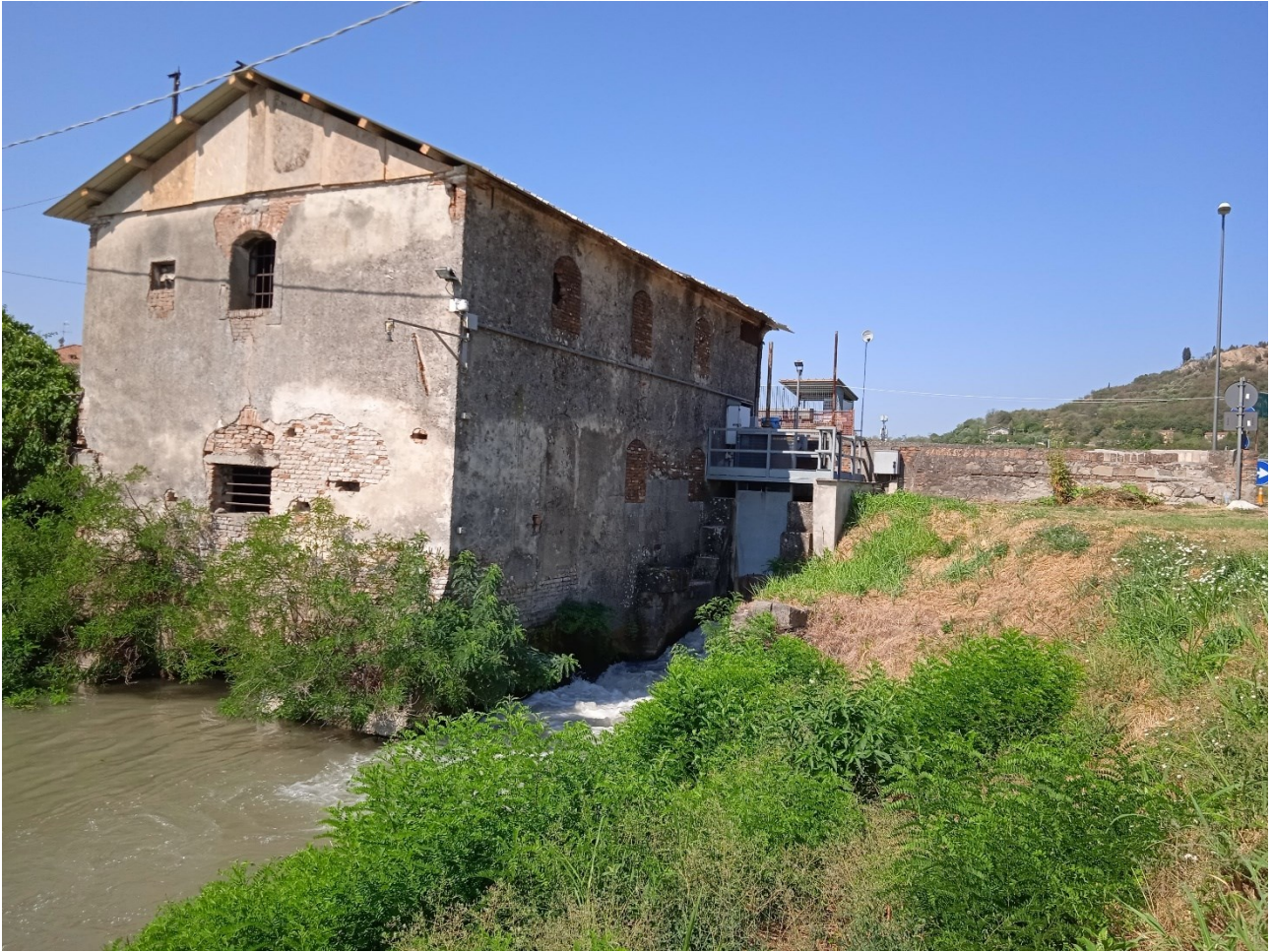
Figura 20 Mulino sul Canale Bagnarolo (sotto-ramo del Canale Bisatto) presso Monselice, uno dei pochi a pale. Oggi al posto della ruota è presente una chiusa (foto dell'autore, 2022)
