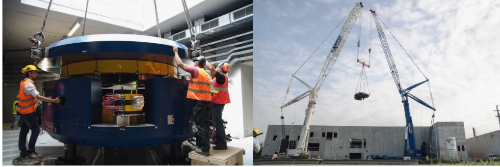
Fig. 1.6: Fasi di installazione del ciclotrone presso i L.N.L. (Maggio 2015)
