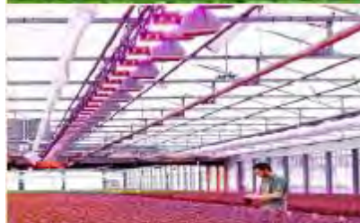
Figura 12: Esempi di illuminazione a soffitto
