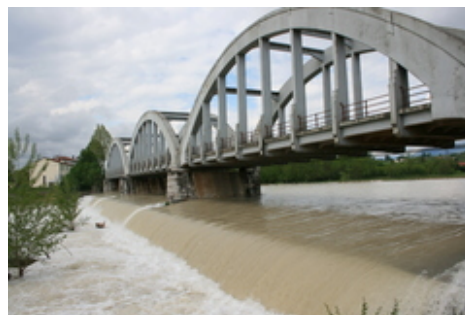
Figura 3.4: Ponte di Breganze
