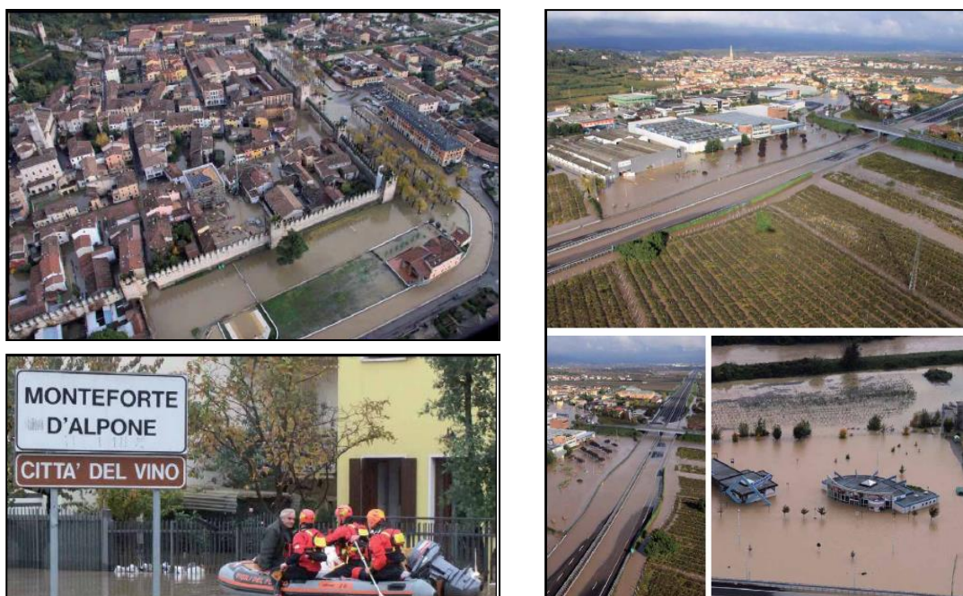
Fig. 3.4: in foto i paesi di Soave (in alto a sinistra) e di Monteforte d'Alpone (an lato a destra e in basso a sinistra e a destra) poco dopo l'evento alluvionale. (Regione Veneto, 2010).
