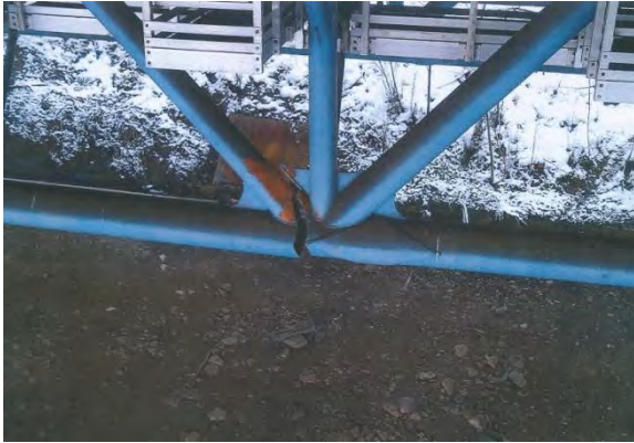
Fig.4.3: Esempio di cedimento a fatica, in una struttura da ponte, indotto dalla presenza di un dettaglio tipo cover plate.
