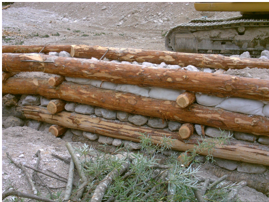
Figura 3.2.6.2.: Opera ultimata con le tue tipologie di riempimento: pietre e sacchi.
