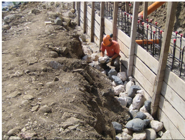
Figura 3.2.1.1.: Operaio forestale durante la selezione del masso all'interno della trincea tra il muro e il terreno depositato come protezione dal torrente.
