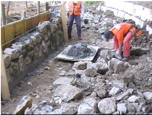
Figura 3.2.3.1.: Particolare del sollevamento di un pesante masso e dell'accidentalità della pavimentazione sulla quale avveniva la MMC.
