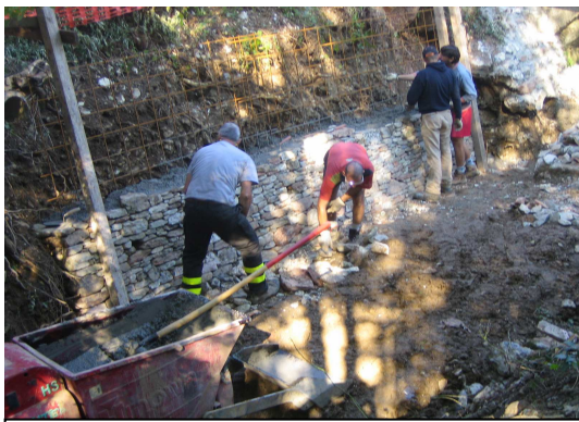
Figura 3.2.5.1.: Area di lavoro e manufatto.
