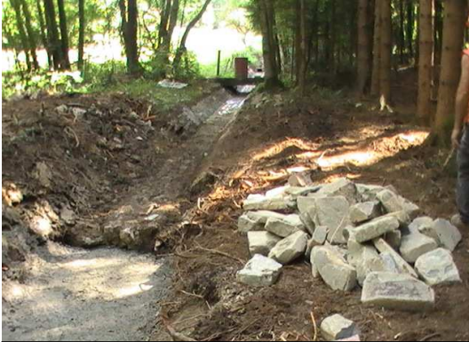
Figura 3.2.4.1.: Cantiere con i massi utilizzati e parte del vecchio manufatto ristrutturato.
