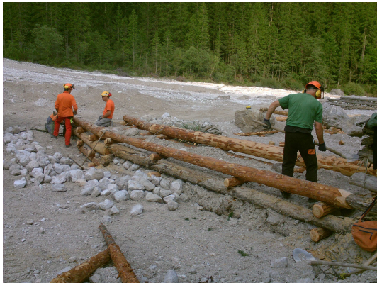
Figura 3.2.6.1.: Pennello in ricostruzione con ammasso del pietrame in prossimità del manufatto.
