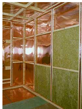
Figura 2.19 - Particolari delle pareti della gabbia
