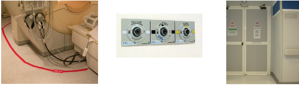
Figura 5.3 - Altri dispositivi di sicurezza: linee isomagnetiche, prese gas medicali, barriere
