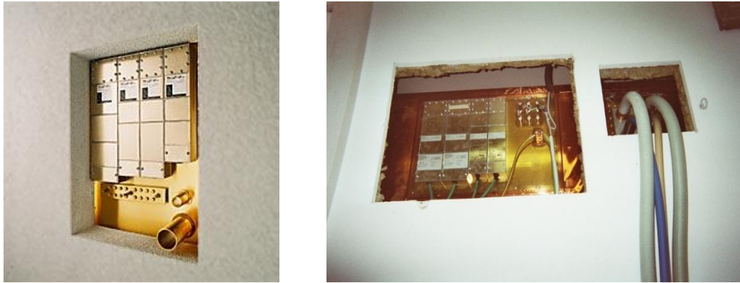
Figura 2.26 - Particolari sui filtri dei servizi entranti
