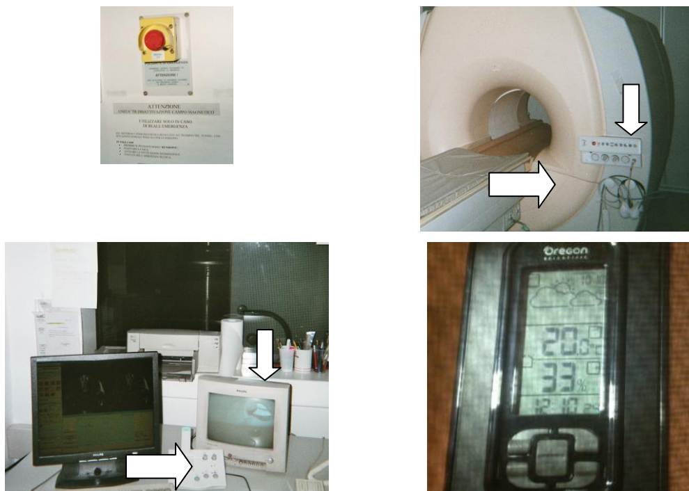
Figura 5.2 - Dispositivi di sicurezza in un presidio RM
