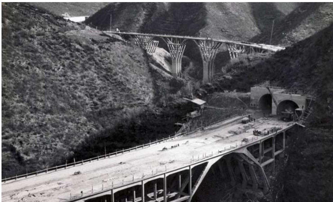
Autostrada del Sole – fasi costruttive
