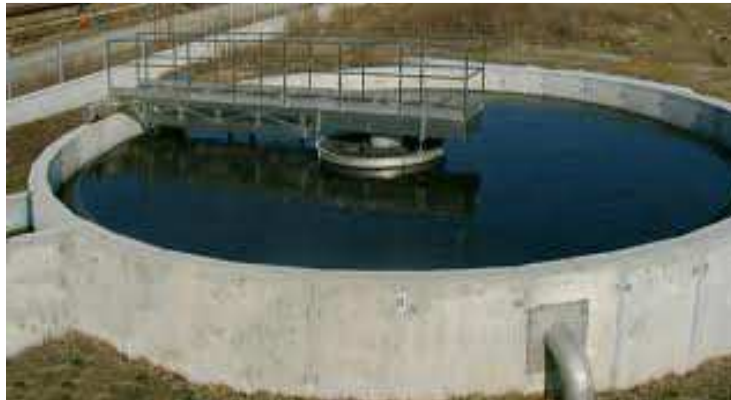
Figura 3.17. Vasca di sedimentazione circolare per il trattamento della sospensione algale.
