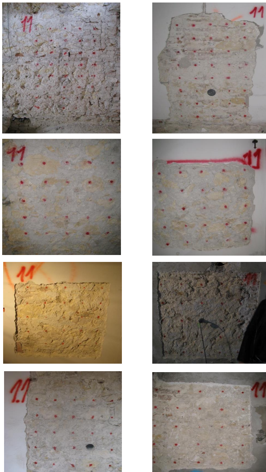
Fig. 7.76: Pannelli 01, 02, 03 e 04 sottoposti a indagine tomografia, facce A (sinistra) e B (destra).
