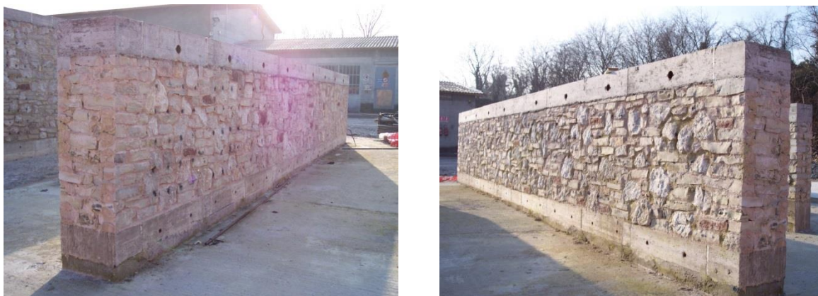
Fig. 4.57 – Prospetto di realizzazione del muro C (sopra) e risultato finale della sua costruzione (sotto) (Fattori e Scaggiante, 2011).
