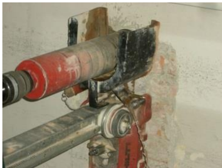
Fig. 2.14 -Esecuzione della prova di carotaggio (Binda et al., 2001c).
