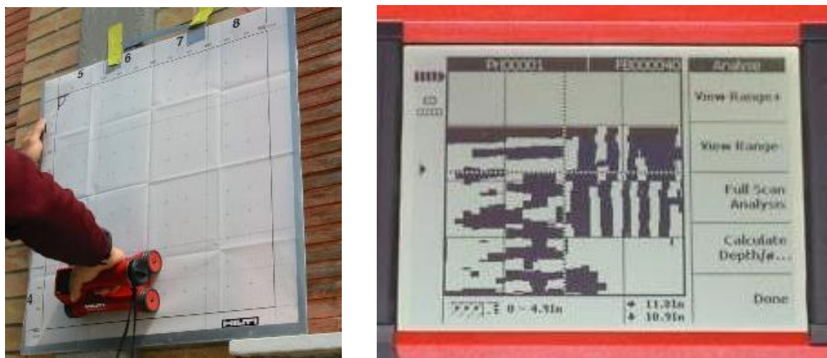
Fig. 2.20 – Esecuzione della prova pacometrica (sinistra) e relativi risultati (destra) (GIEPI S.r.l.).
