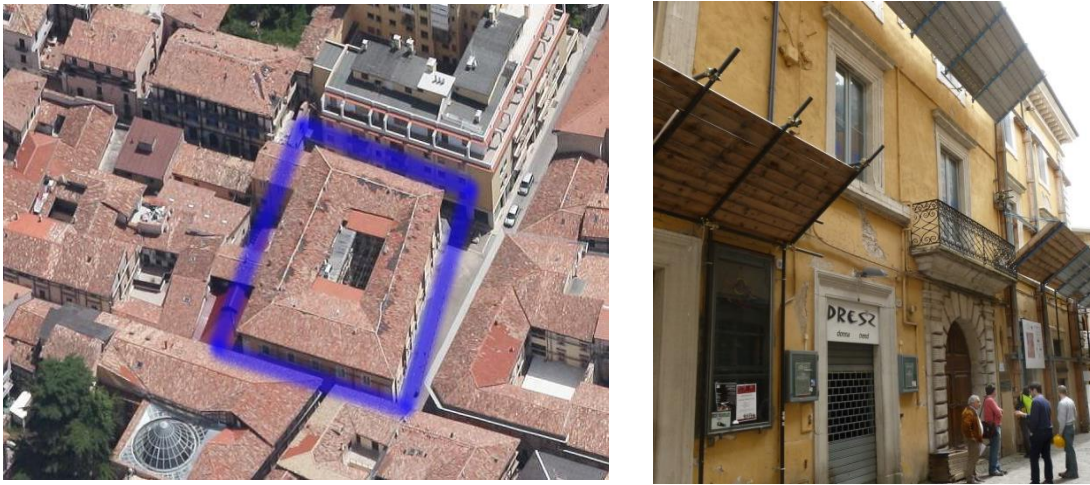
Fig. 7.25: Localizzazione dell'aggregato 1005 (sinistra) e immagine della facciata esterna rivolta verso Corso Vittorio Emanuele (destra).
