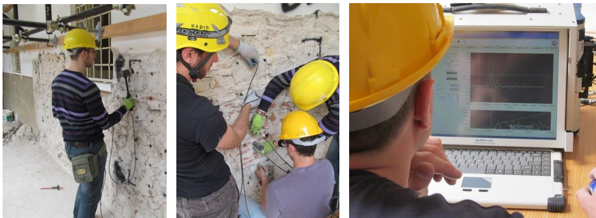
Fig. 7.31: Alcune fasi di esecuzione delle prove tomografiche.
