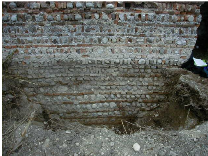
Fig. 4.9 – Pannello sottoposto ad indagine tomografica (Da Porto, 1999).
