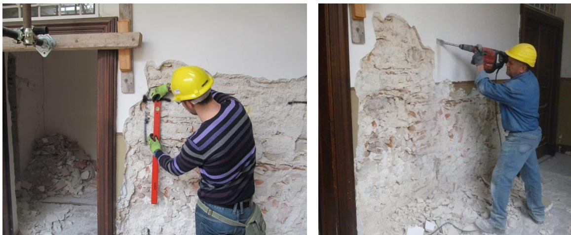
Fig. 4.2 – Individuazione della miglior posizione possibile per il pannello di prova (sinistra) e scarificazione di una parete da indagare (destra).
