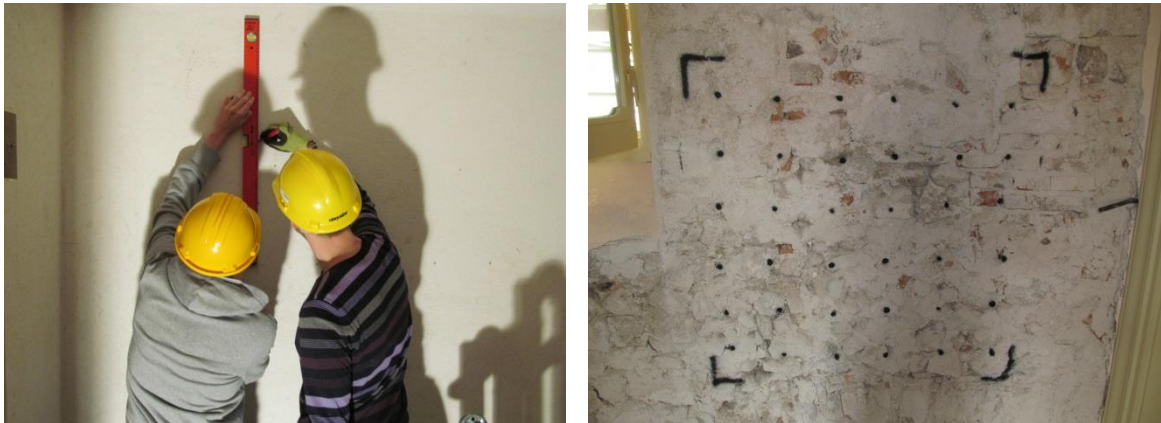
Fig. 4.3 – Disposizione dei punti di misurazione (sinistra) e maglia di acquisizione completa (destra).
