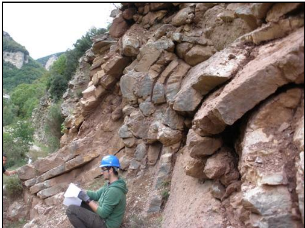
Fig.10 - Strati interessati dallo slump.
