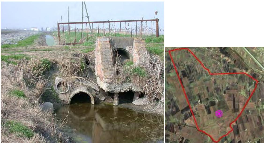
**Figura 2.7: vecchio tombino in muratura ormai totalmente protruso abbondantemente al di sopra del livello dell'acqua e quindi sostituito con due tombini in calcestruzzo di cui il più alto già affiorante**
